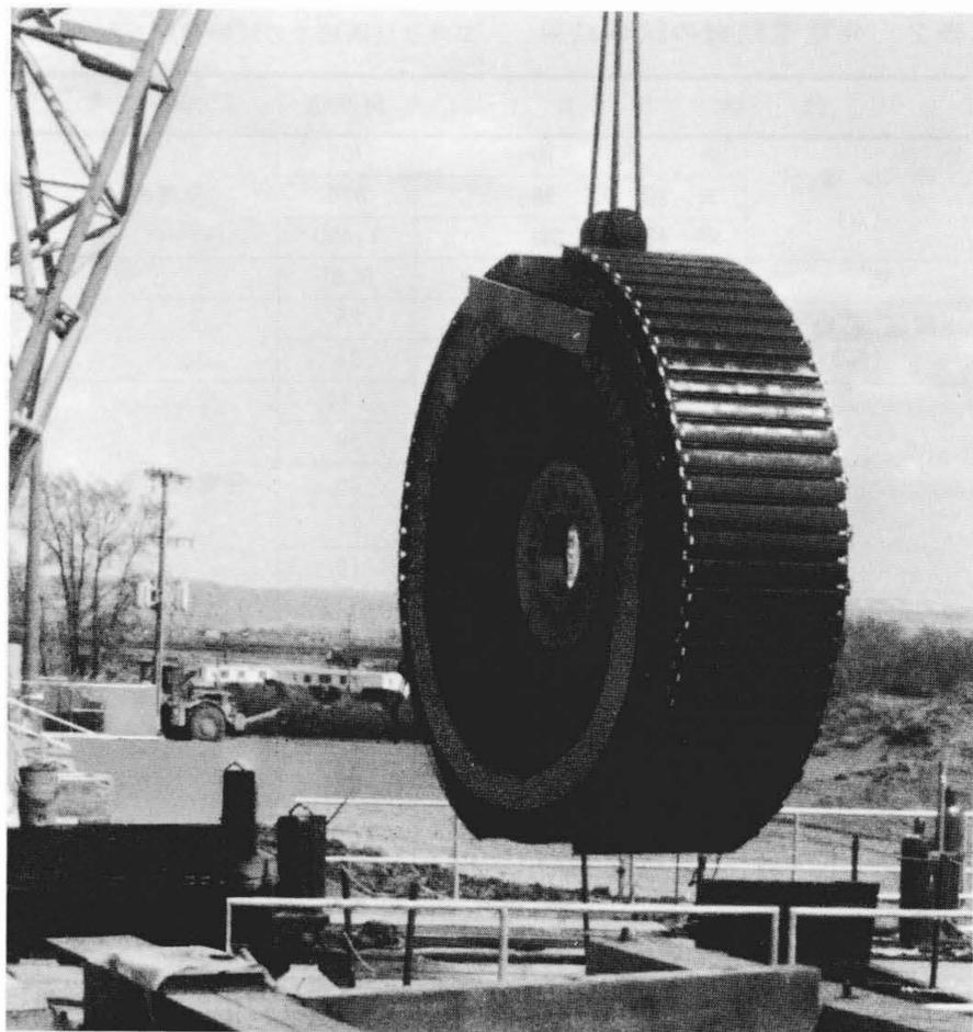
図12 回転子のつり込み 現地での回転子つり込み状態を示す
