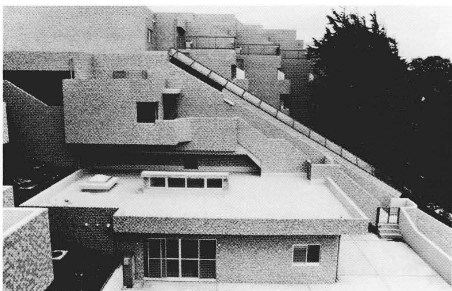
図15 斜行エレベーター1号機を納入したマンション「インペリアル菊名」と昇降路の外観
