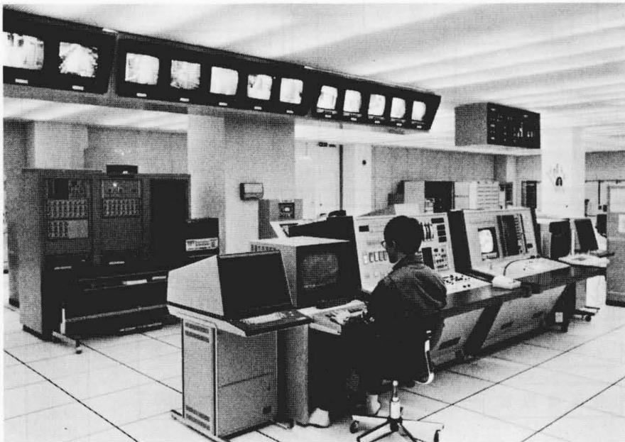
図3 中央制御室 中央操作盤, CRT操作盤, ITV操作盤などにより, 運転の集中管理を行なう。
