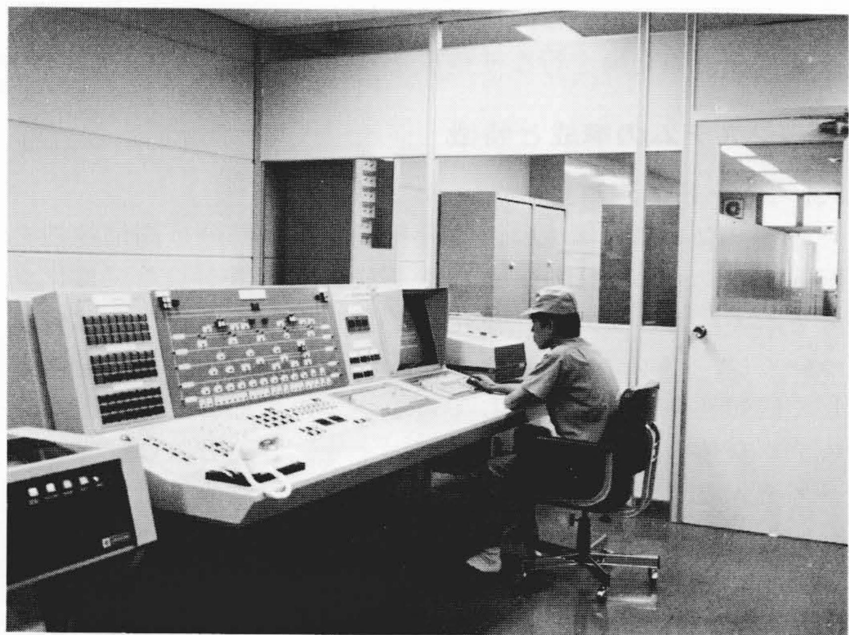
図5 原加計装制御・中央監視システム 工場全体の監視を中央監視室で行なう。
