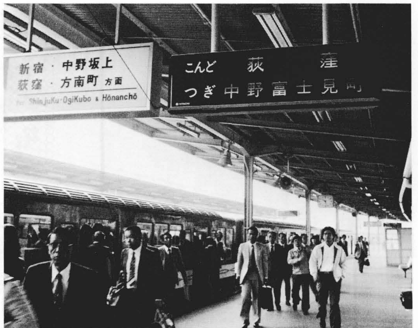
図8 大形液晶表示器による列車行先案内表示器の例 透明カバーの横巻き構造により、軽快感を出した。
