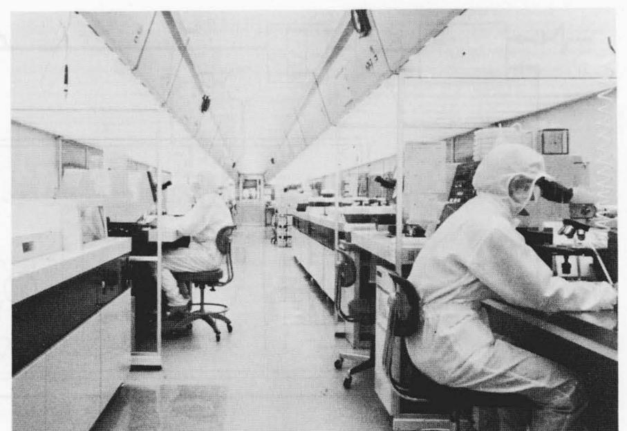
図6 クリーントンネルの室内 この写真の例では中央部が平坦床であるが、グレーチング床として気流が床下に流れるようにする方法もある。
