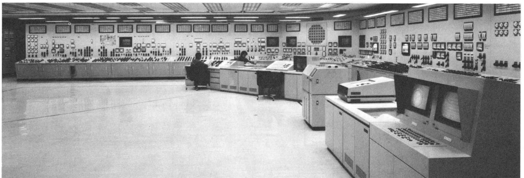
図1 福島第二・2号機中央監視制御装置 中央制御室の中央監視制御装置に、原子力発電所の膨大な情報を集約し、中央制御室からすべての運転操作が行なえるように設計している。
