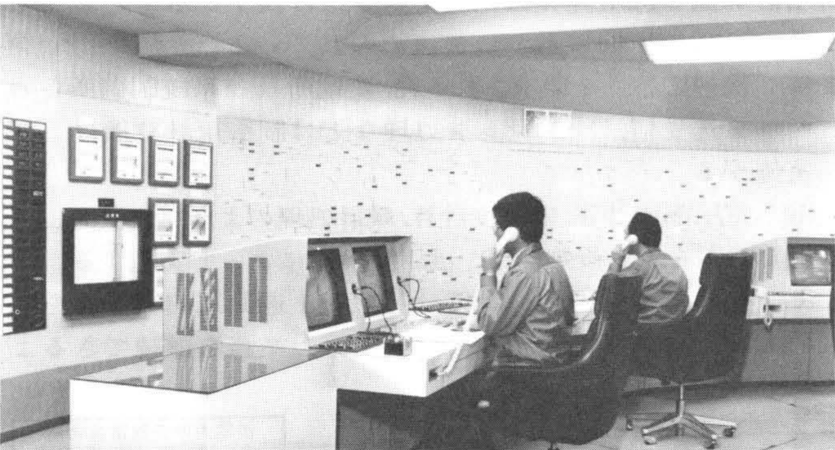
図 2 中央給電指令所指令室 常時3人のオペレーターがCRT，ライトペンを用いて対話形式で監視・制御を実施する。
