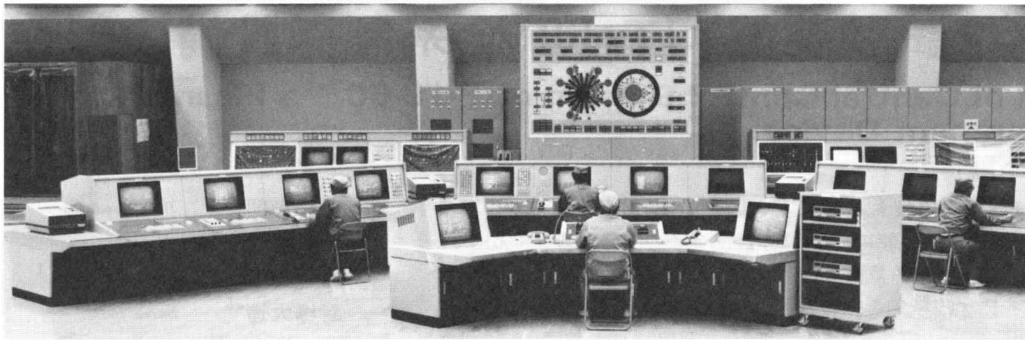
図2 全系制御設備の外観 JT-60の運転及び実験は、中央制御室の計算機化制御盤による集中制御方式で行なわれる。手前から、総括コンソール、中央コンソール、補助グラフィック盤を示す。
