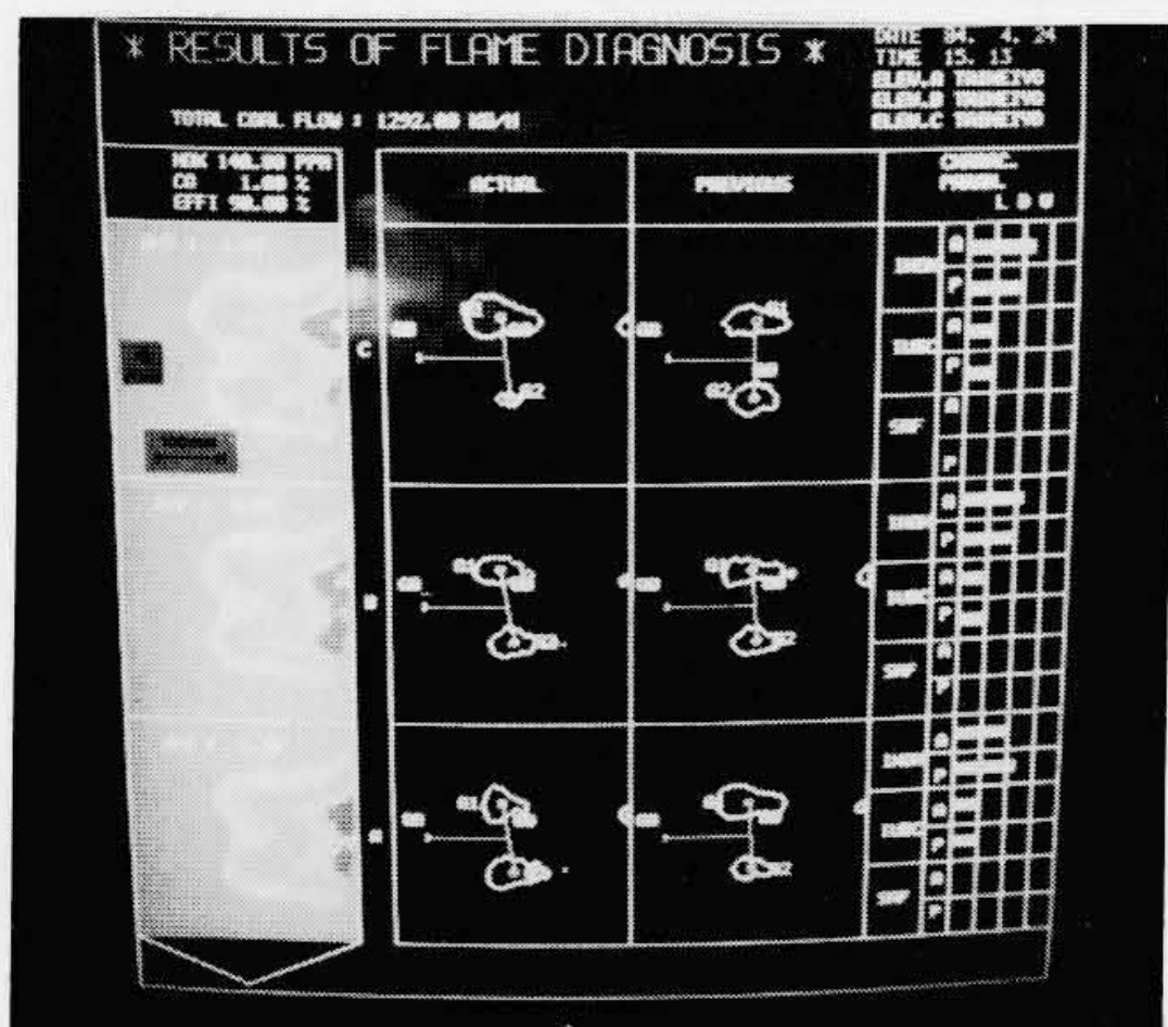
図23 燃焼監視状況表示例
