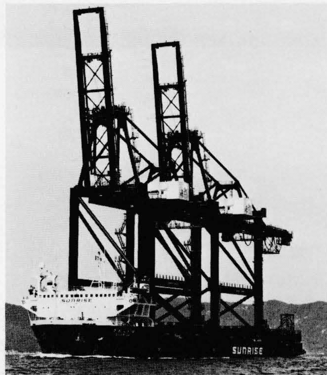
図43 大形コンテナクレーンの総組海上発送
