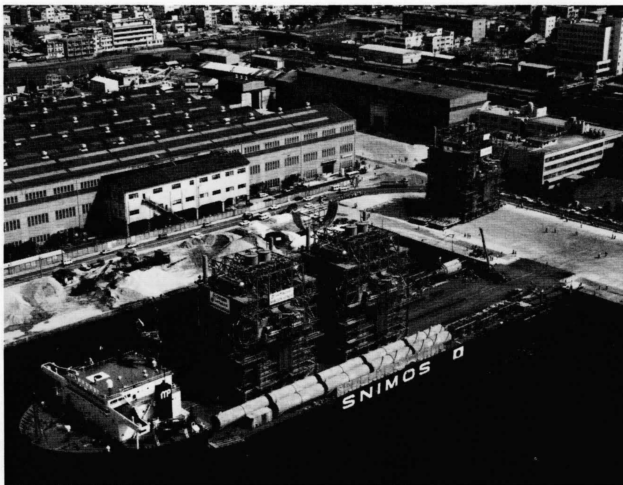
図6 千代田化工建設株式会社向けアラビアンペトロケミカルカンパニー納め分解炉モジュール
