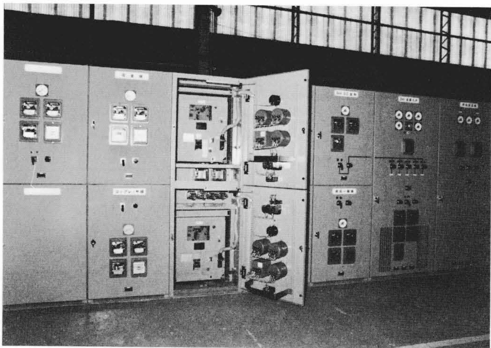
図8 6.9kV 2段積・大容量メタルクラッド配電盤 真空遮断器は低サージ化などとともに大容量化が進んでおり、本図は7.2kV、3,000A遮断容量40kAのVCBを収納した2段積の大容量メタクラの外観である(高さ2,300mm)。
