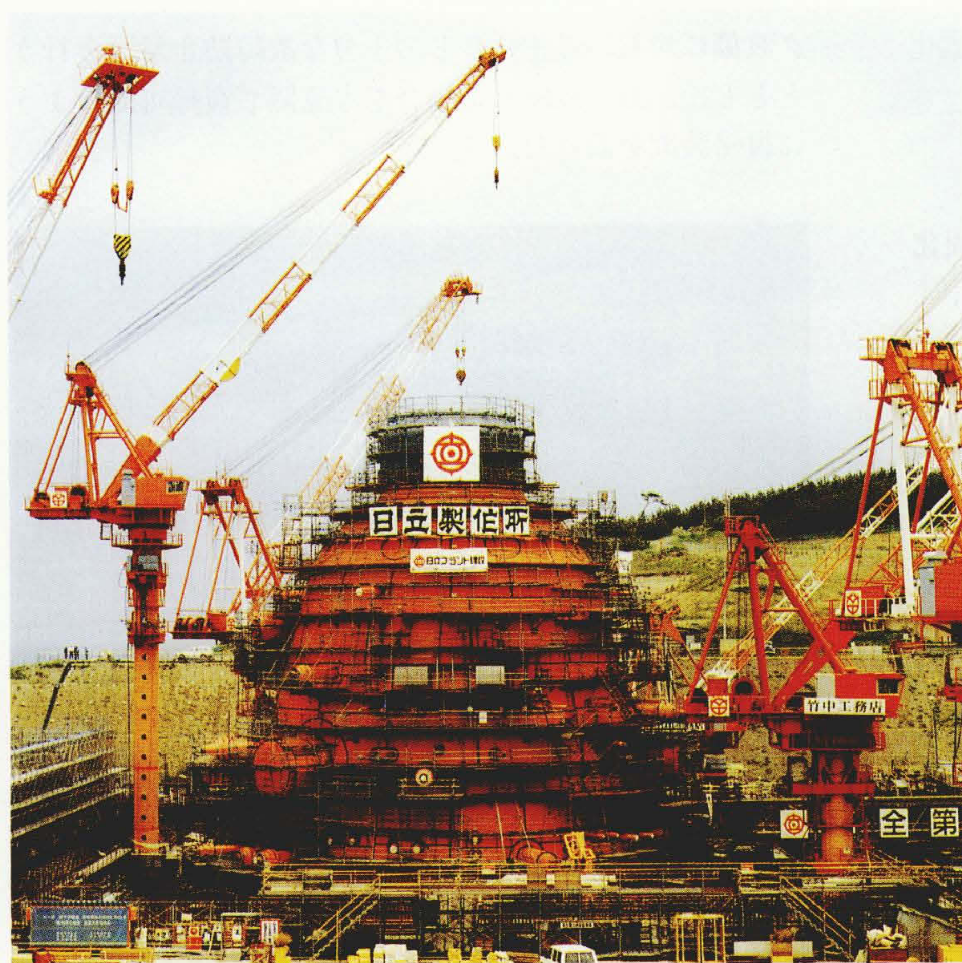
東京電力株式会社柏崎刈羽原子力発電所5号機の建設状況 (昭和61年8月)
