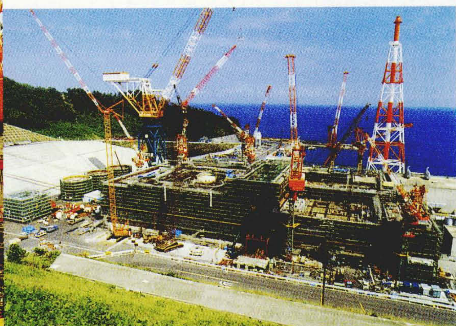
中国電力株式会社島根原子力発電所2号機の建設状況 (昭和61年8月)
