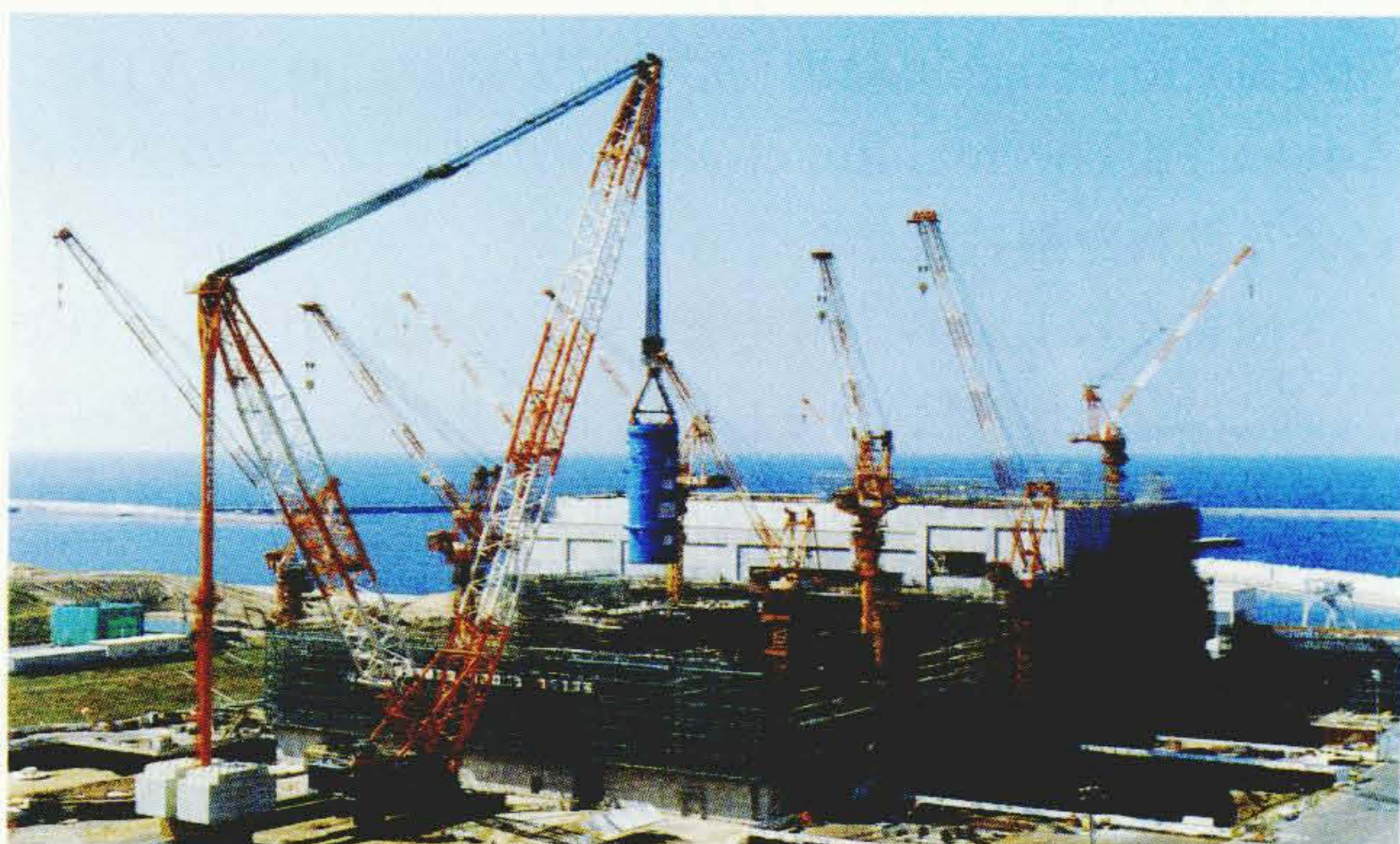
東京電力株式会社柏崎刈羽原子力発電所5号機の原子炉压力容器つり込み
