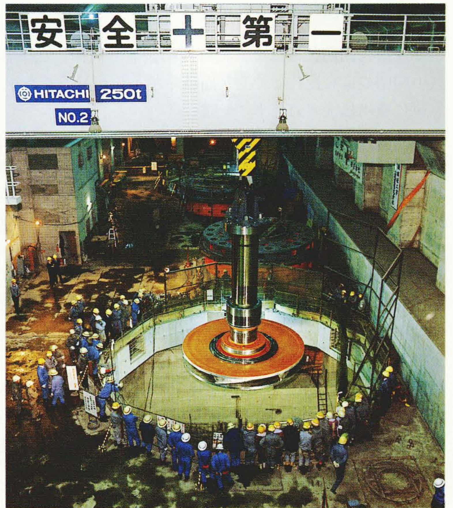
308 MWポンプ水車ランナ現地つり込み
