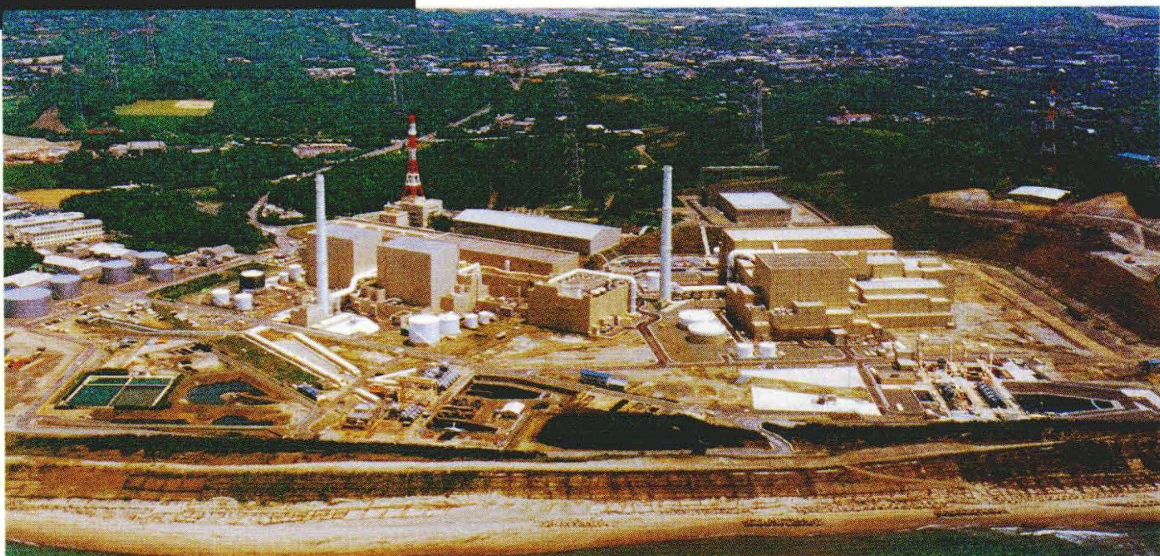
中部電力株式会社浜岡原子力発電所 (右側が3号機)
