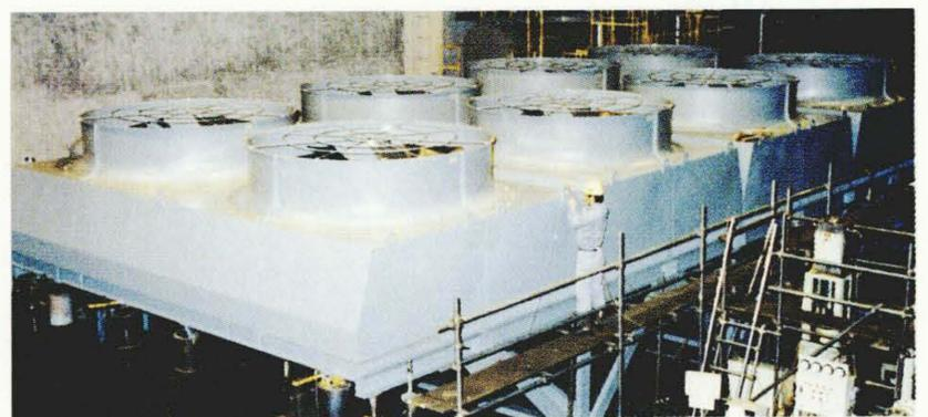
HC-19C-AH空気熱交換器ユニット外観
