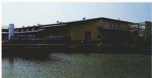
熱工法などを開発し、収容量7,000 tの大形超低温冷凍庫を実用化した。
