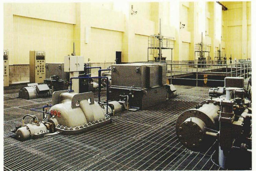
出力 $4.1\text{ MW}$ の揚水ポンプ設備
