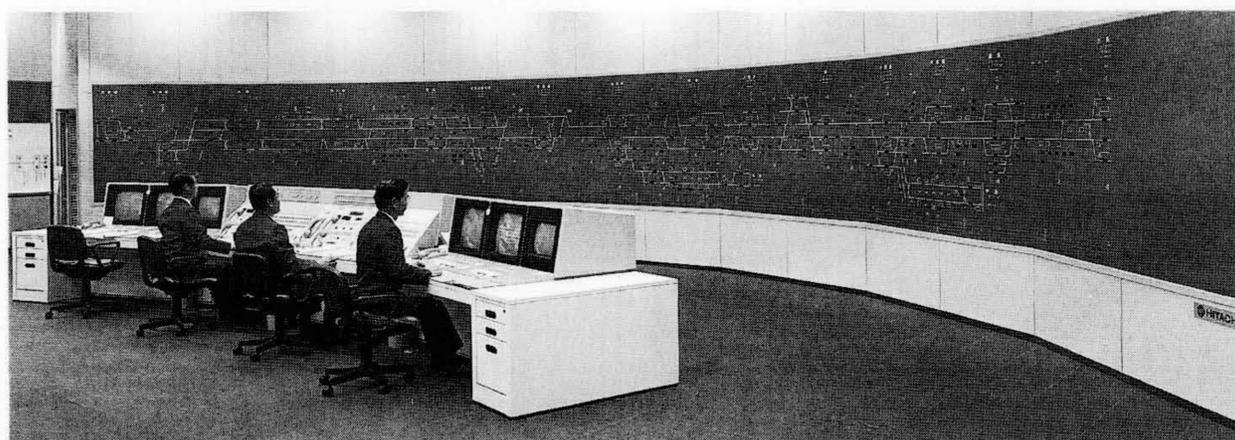
図4 京阪電気鉄道株式会社運転指令室 モザイク式の運行表示盤によって、将来の配線変更などに容易に対応可能としている。
