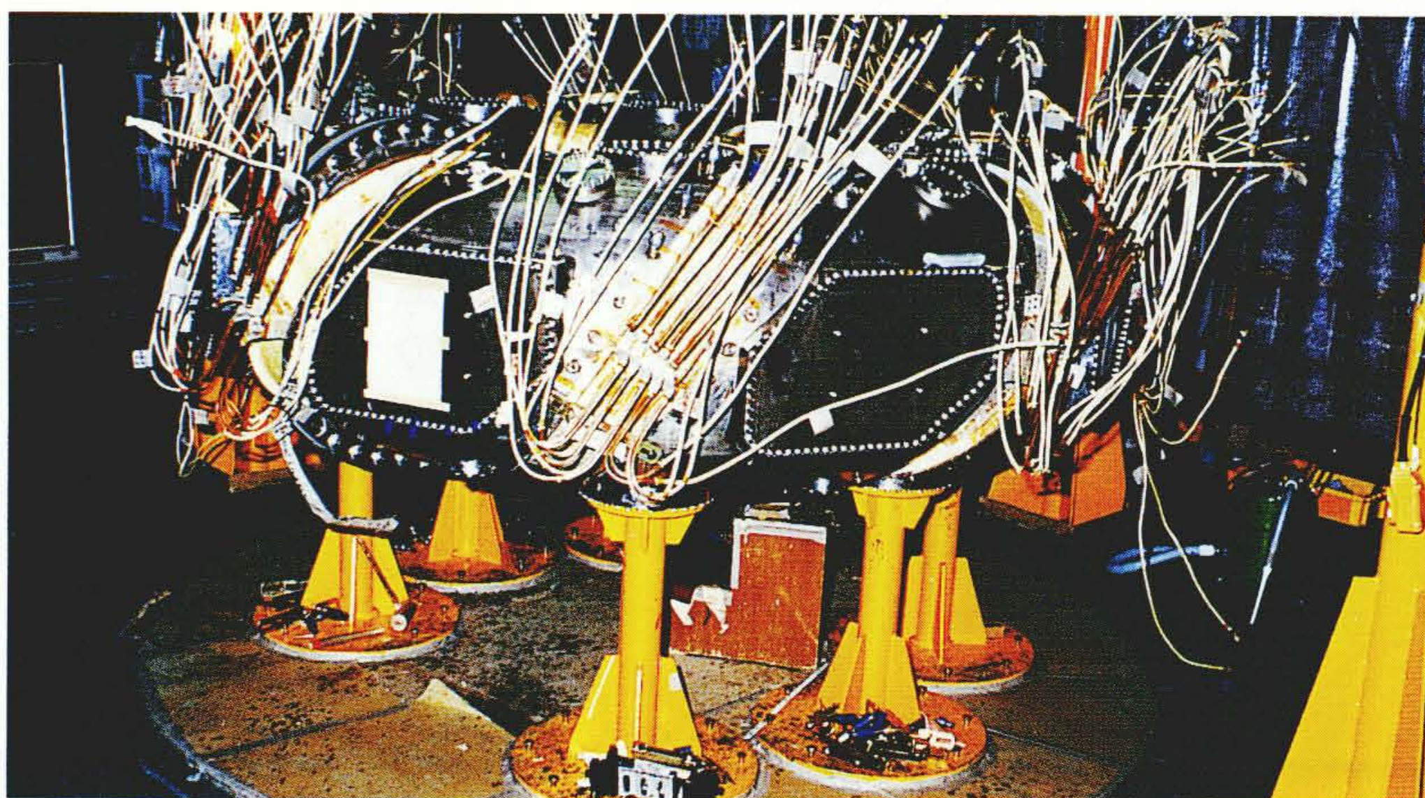
名古屋大学プラズマ研究所納め コンパクトヘリカルシステム (らせん状コイルの巻き付け)
