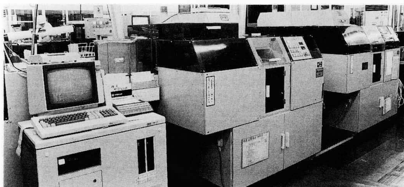
図5 自動化設備の概要 CIM化のために、図に示す一貫ラインを構成する高信頼度な自動化設備が不可欠である。
