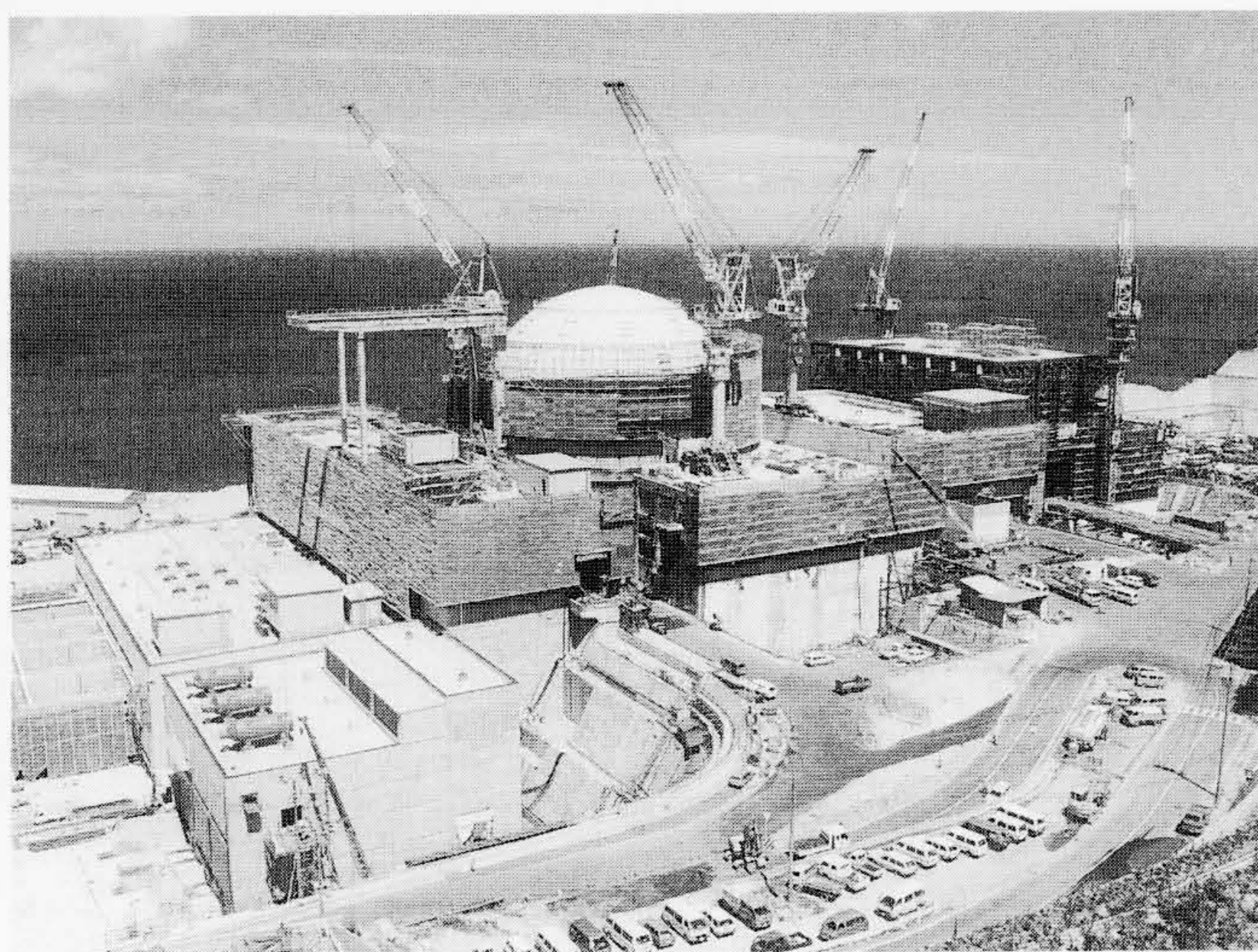
図5 「もんじゅ」サイトの現況 福井県敦賀市白木地区で行われている「もんじゅ」サイトの建設工事の現況を示す(平成元年7月25日撮影)。
