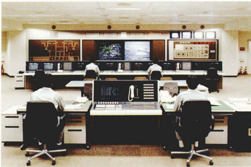
図3 大阪ガス株式会社泉北製造所第一工場でのガスプラントに実装した70形2面高精細ディスプレイの外観 従来のグラフィックパネルと併存してシステムを構成している。
