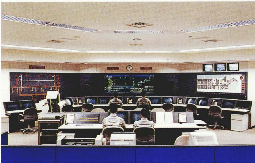
図8 大阪ガス株式会社泉北製造所第二工場での70形2面マルチスクリーンディスプレイの実装図 70形を5mm以下のすきまで横2面に接続し、2,560×1,024ドットの一画面を構成した例である。
