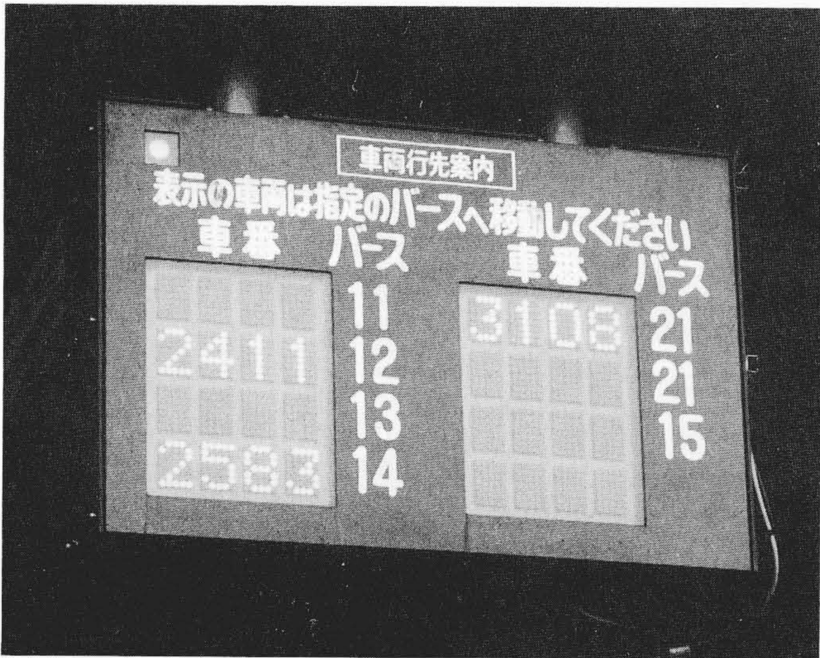
図10 トラック行き先表示盤 音声呼び出し装置と合わせて、的確な出荷車両の誘導を行う。
