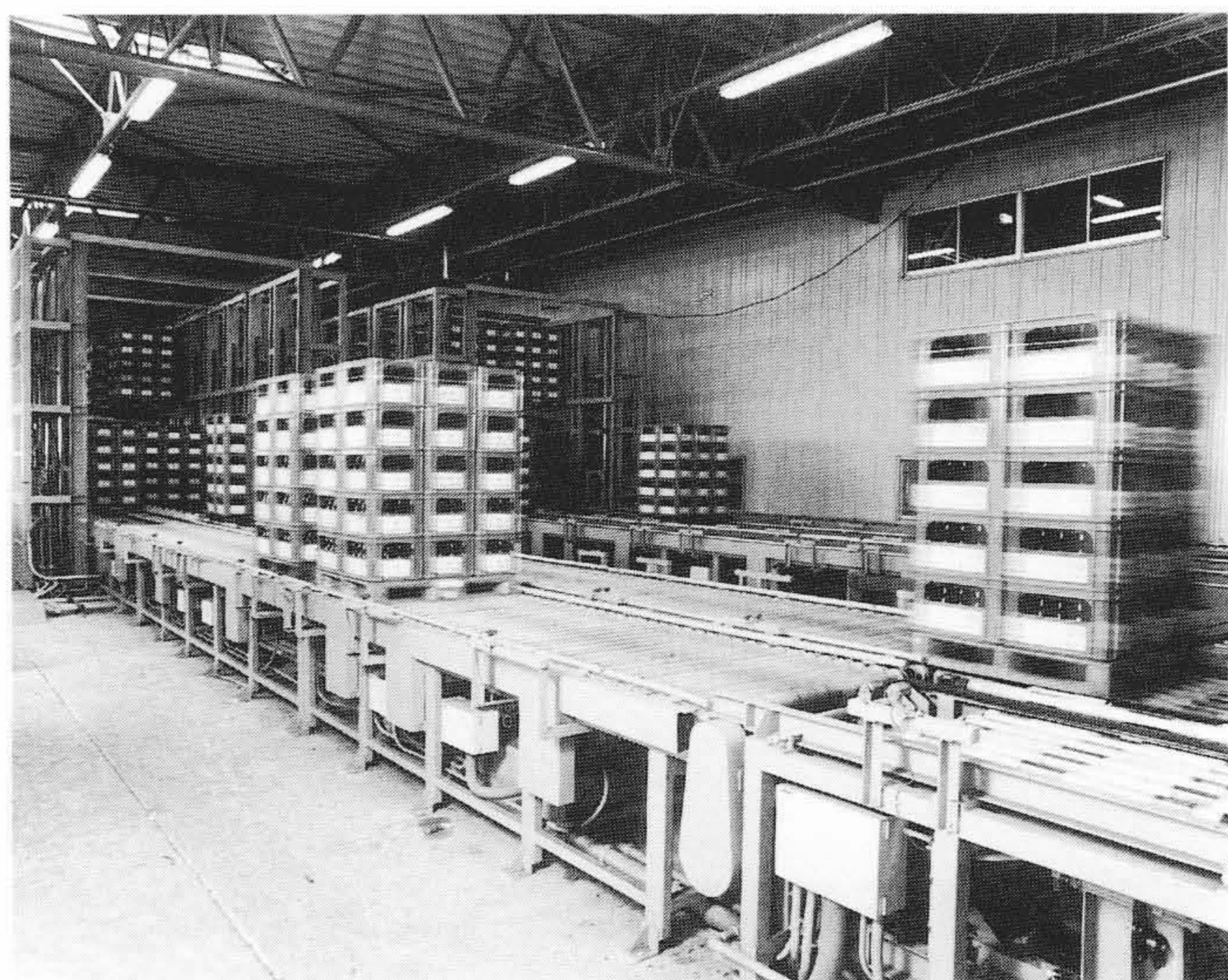
図12 出荷品自動整列装置 出荷品はあらかじめトラック荷台への積み込み順が決められており、油圧リフトで持ち上げながら整列される。
