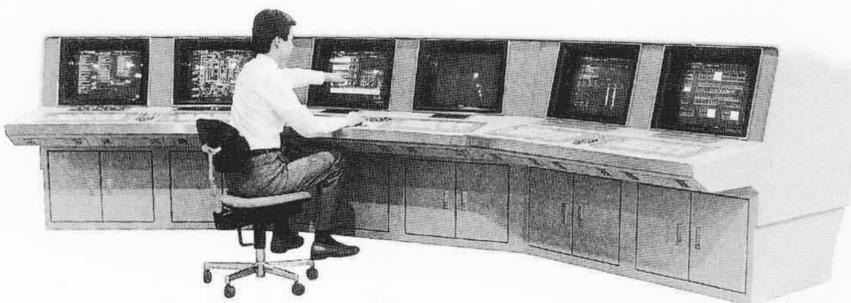
図10 総括制御盤の機能と構成 写真は柳井発電所の総括制御盤を示すもので，2系列1,400 MW発電設備およびLNG設備とユーティリティ設備などを，二人の運転員で運転監視できるように，人間工学の立場から模擬盤の検討を踏まえ製作した。
