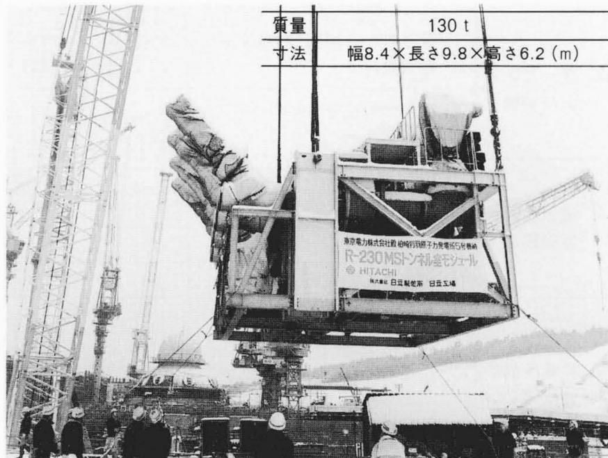
図4 機器・配管・弁ブロックモジュール化工法の拡大 工場での機器・配管・弁類をブロックモジュール化することにより、現場内作業の削減および製品の品質向上を図った。
