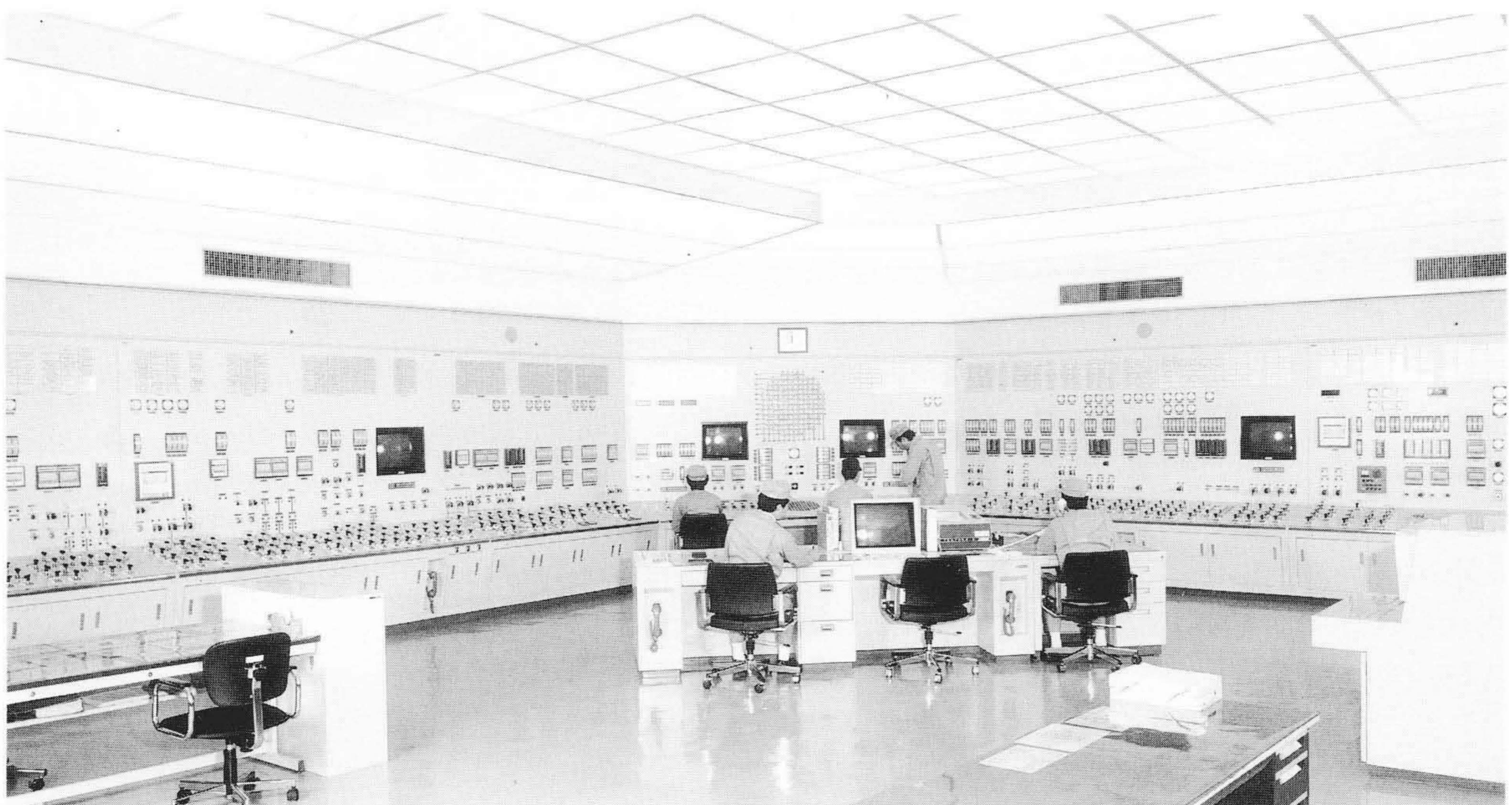
図2 島根2号機試運転中の中央制御室全景 島根2号機中央制御盤は1号機中央制御室と同室にあり、盤形状、スイッチの配列など1号機と調和をとった配置になっている。
