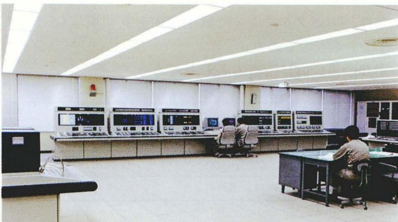
浄水場のOA、EA業務とプラント運転業務とを統合した新しい概念の情報・制御統合システム
