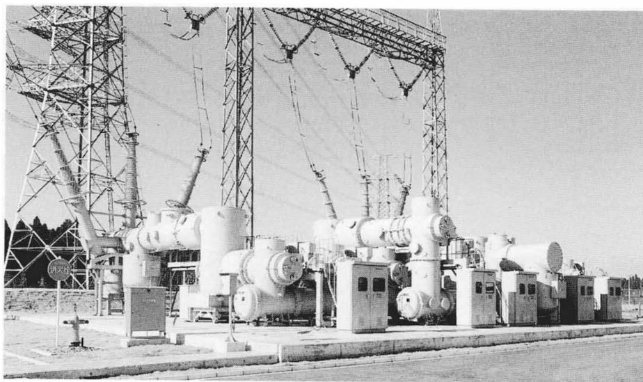
図5 300 kV GIS全三相一括化の効果 全三相一括化により、据付け面積を62%に縮小化した。
