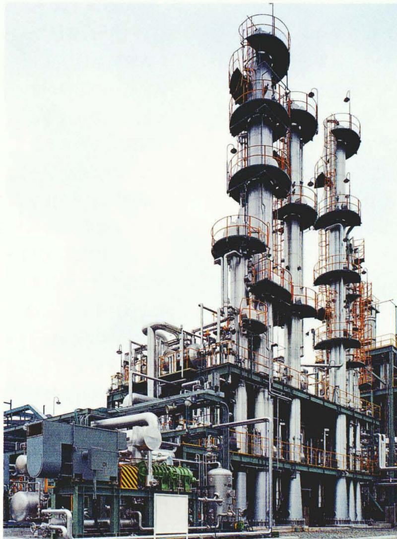
昭和電気株式会社川崎工場納め代替フロン製造設備の全容 この装置は昭和電気株式会社が開発した気相法を用い、HFC-134a製造用の商業プラントである。年間5,000 tの能力を持つ。
