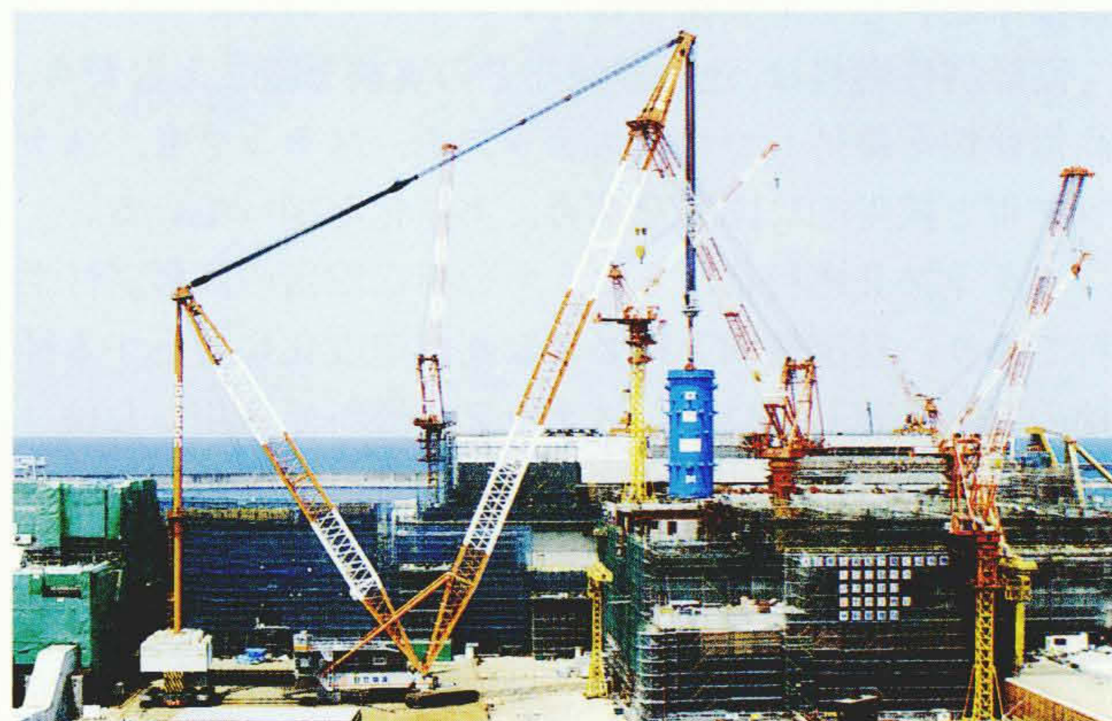
東京電力株式会社 柏崎刈羽原子力発電所4号機での大型クローラークレーンによる原子炉圧力容器つり込み
