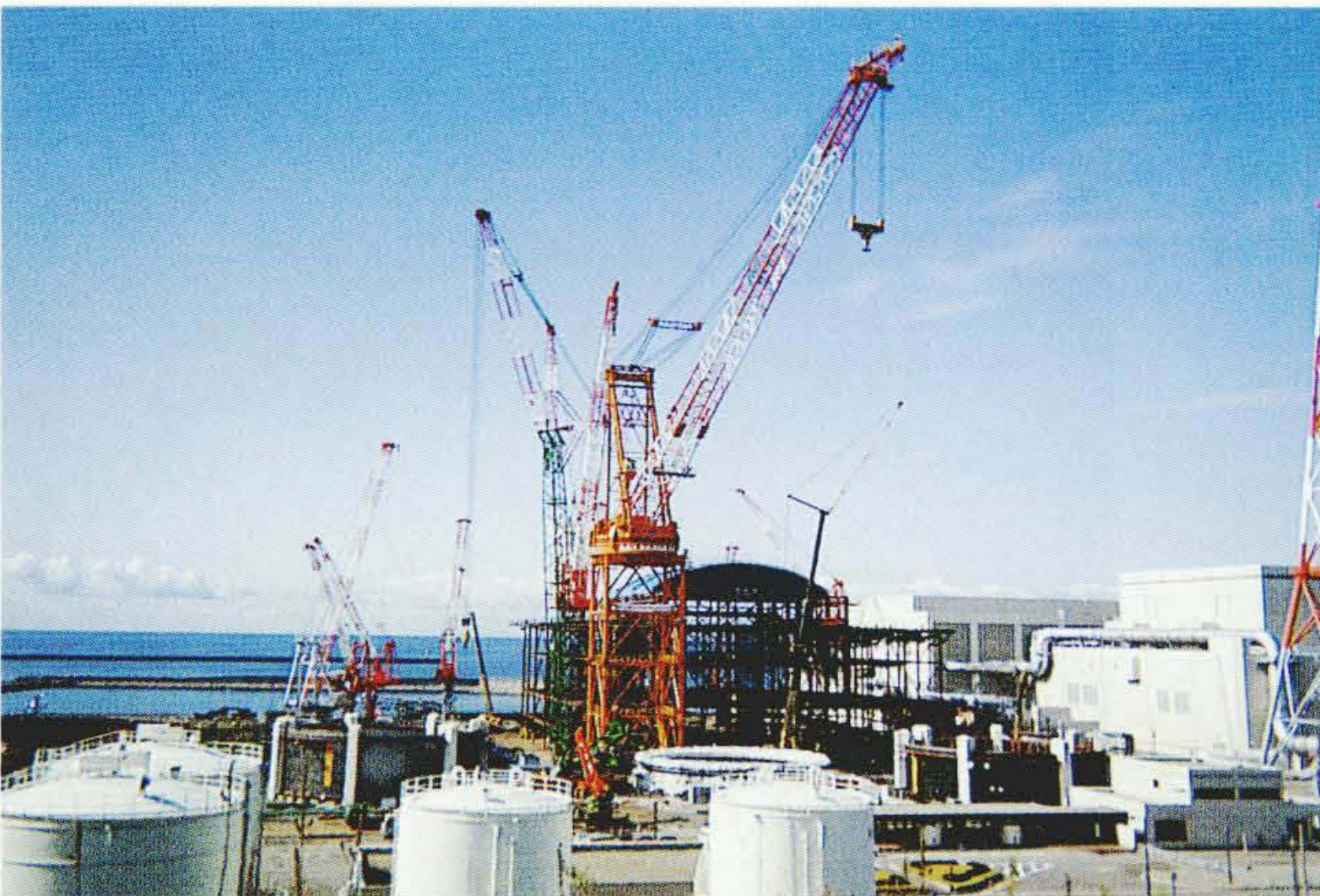
着工した東京電力株式会社 柏崎刈羽原子力建設所6号機建設現場
