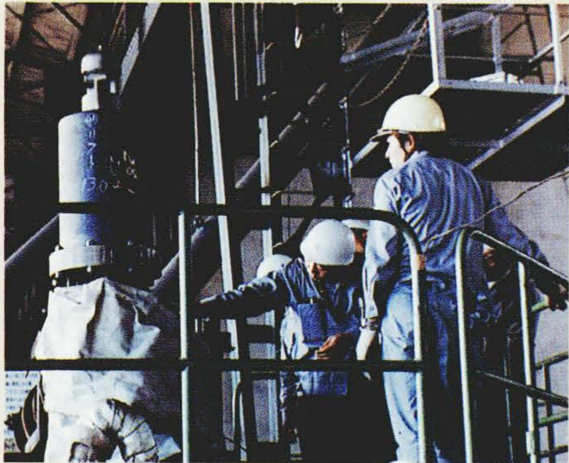
バルブの検査作業
