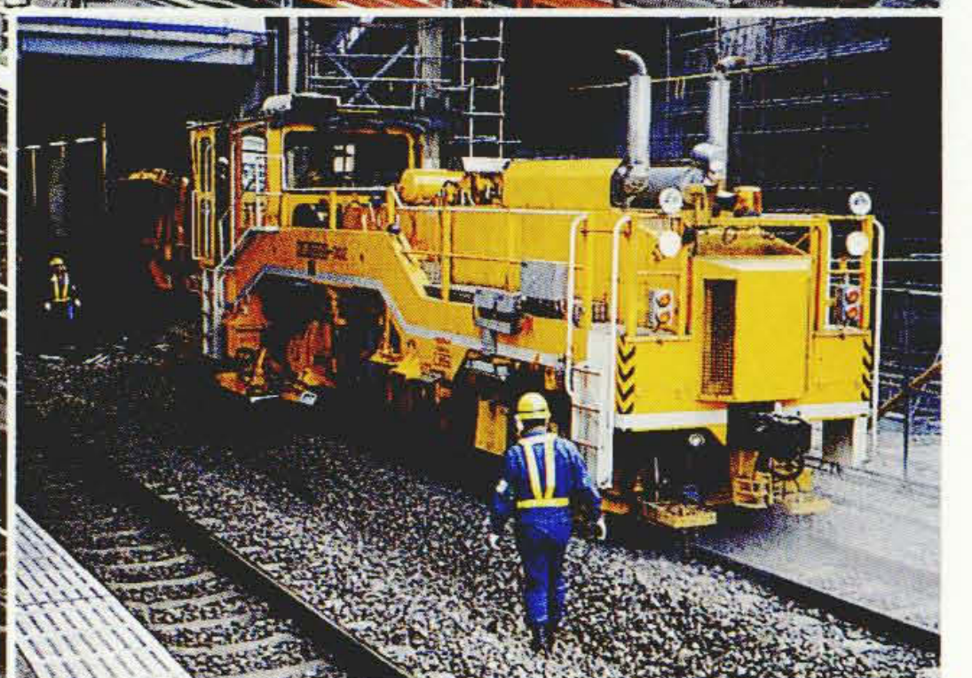
保守作業風景
