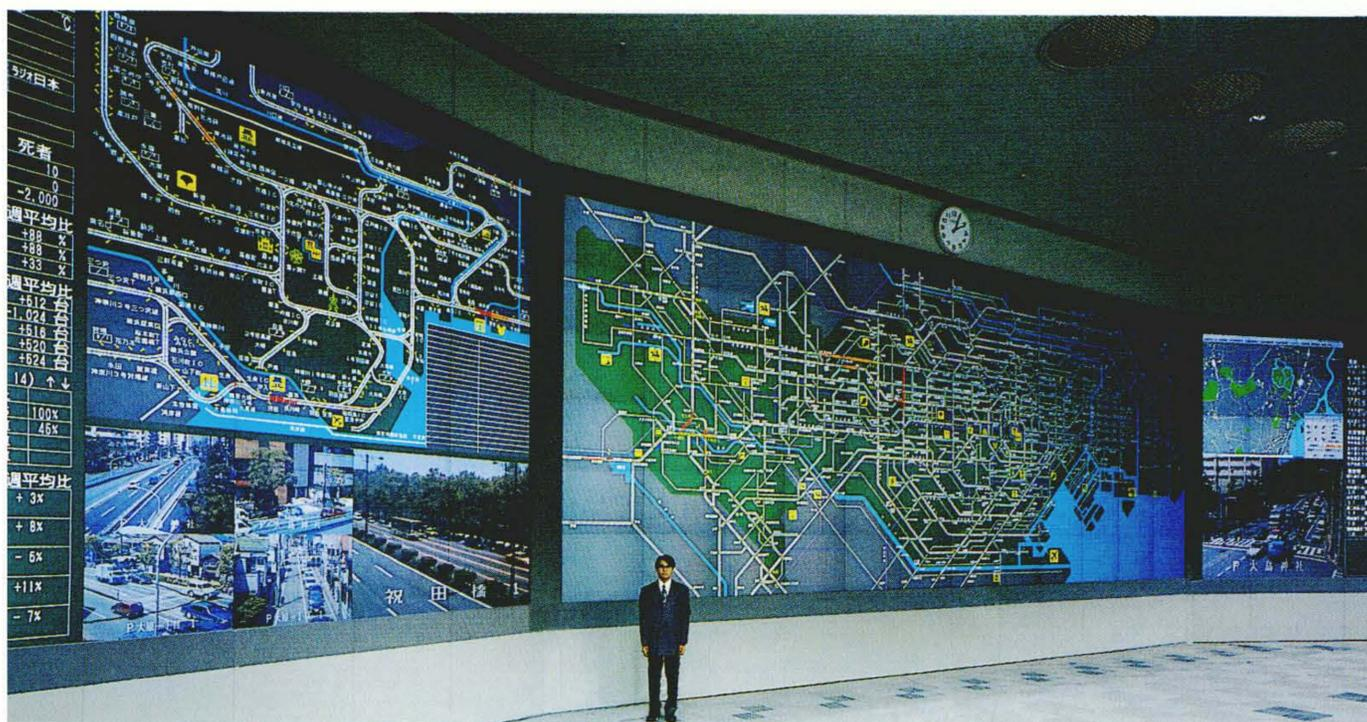
警視庁の新交通管制センターの超大型マルチスクリーン。背面投写型50型高精細ディスプレイを144面使用、全体では縦約6m、横約25mに及ぶ巨大なスクリーンである。
