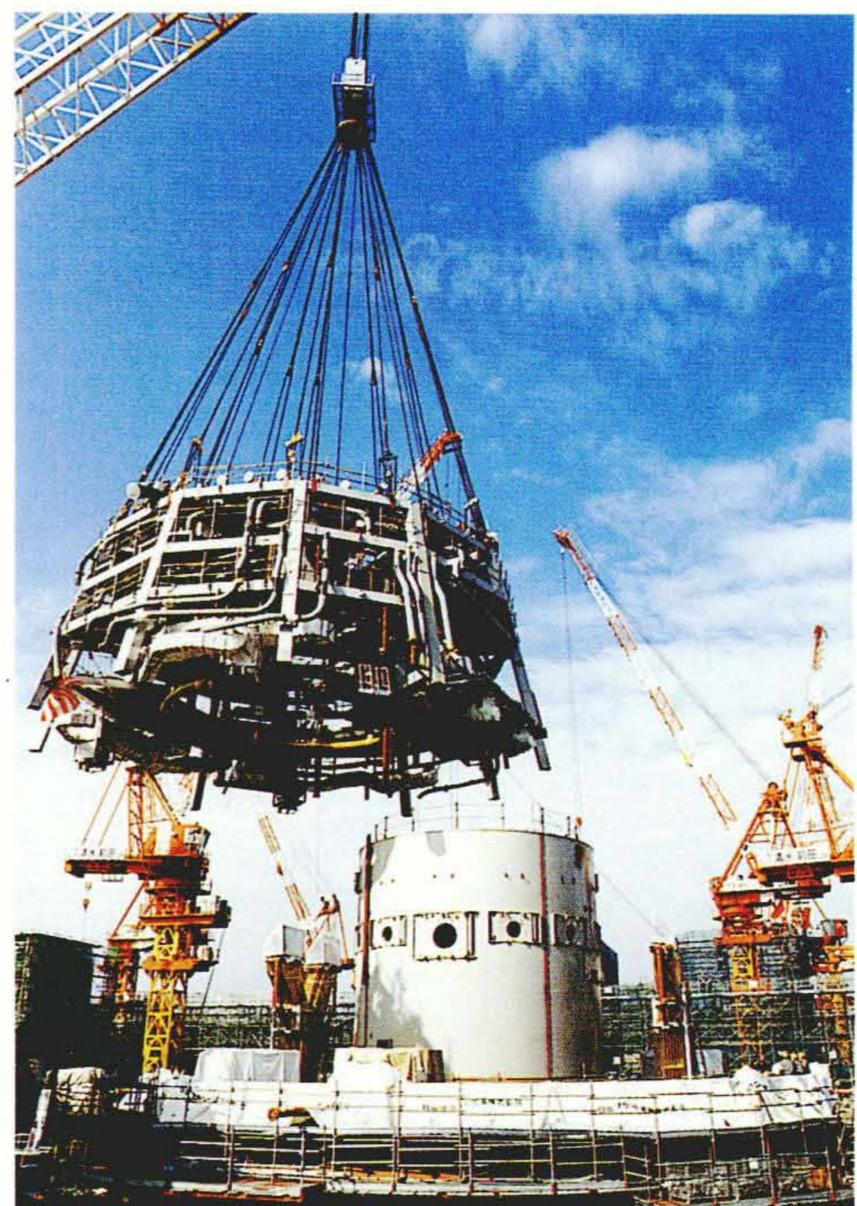
図6 原子炉格納容器内機器超大型モジュール 原子炉格納容器内作業の先行消化と平準化を達成した。
