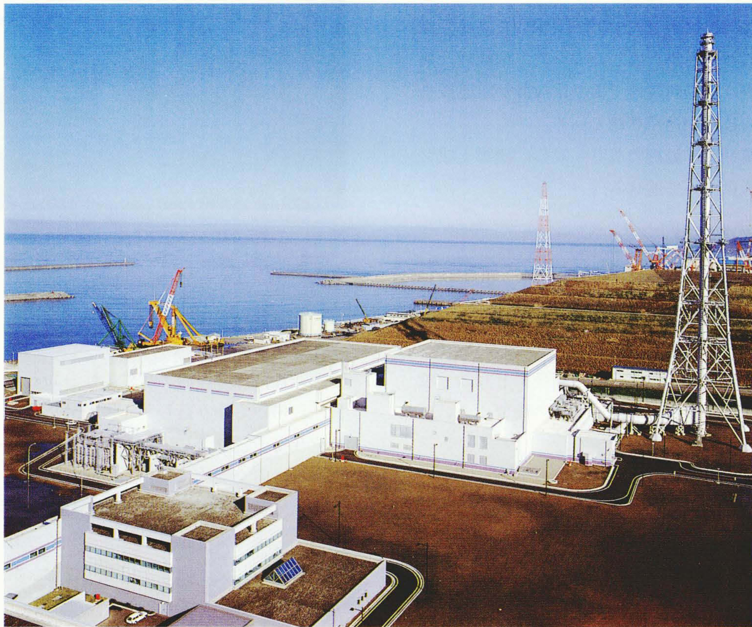
東京電力株式会社柏崎刈羽原子力発電所4号機の外観
