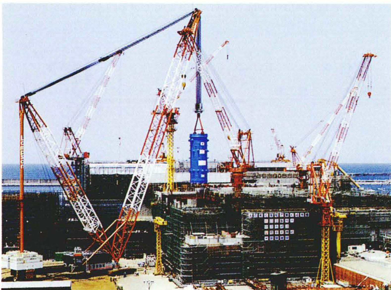
図5 大型移動式クレーン 重さ750tの原子炉圧力容器を直接つり込む大型移動式クレーンを示す。
