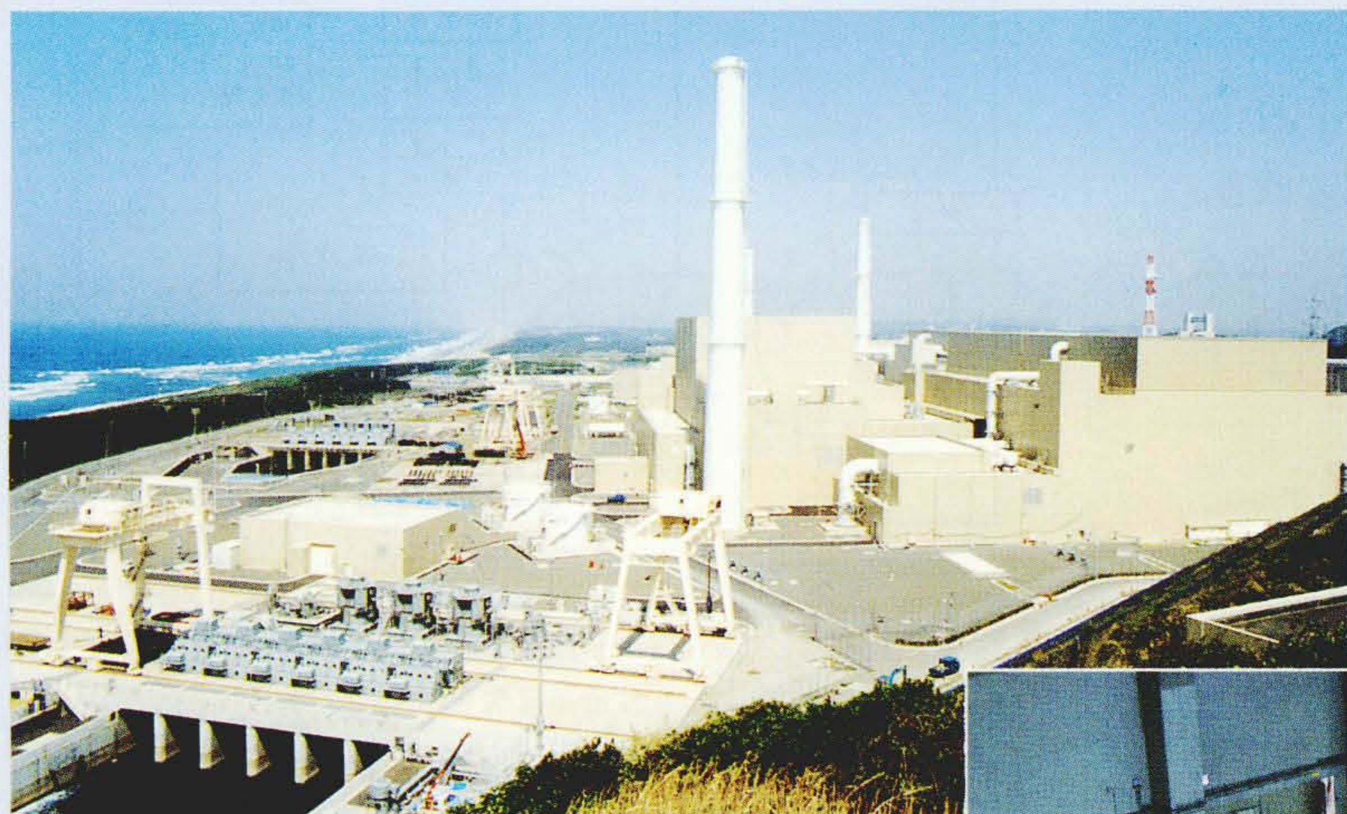
中部電力株式会社浜岡原子力発電所 4号機
