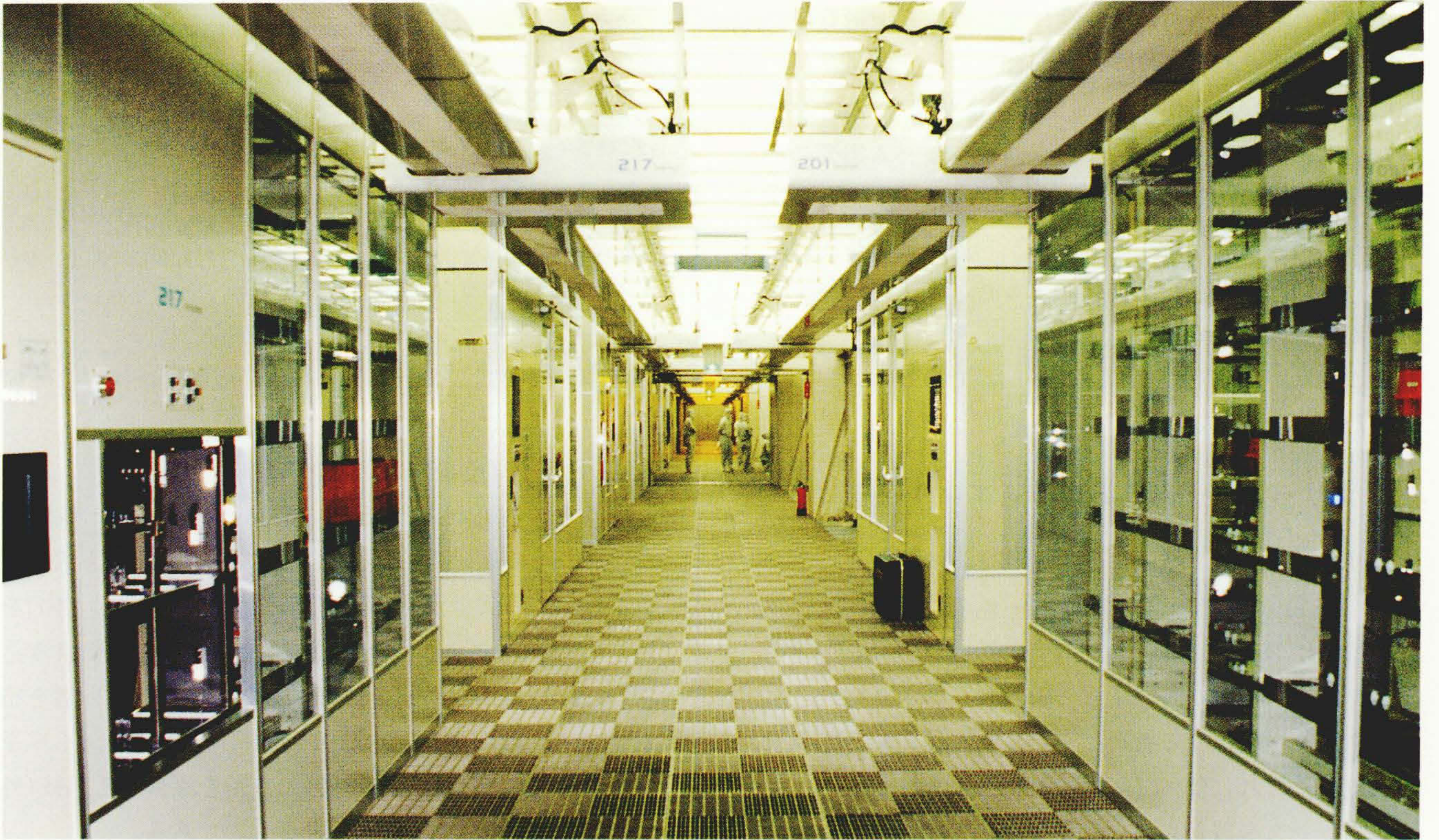
クリーンルーム内部
