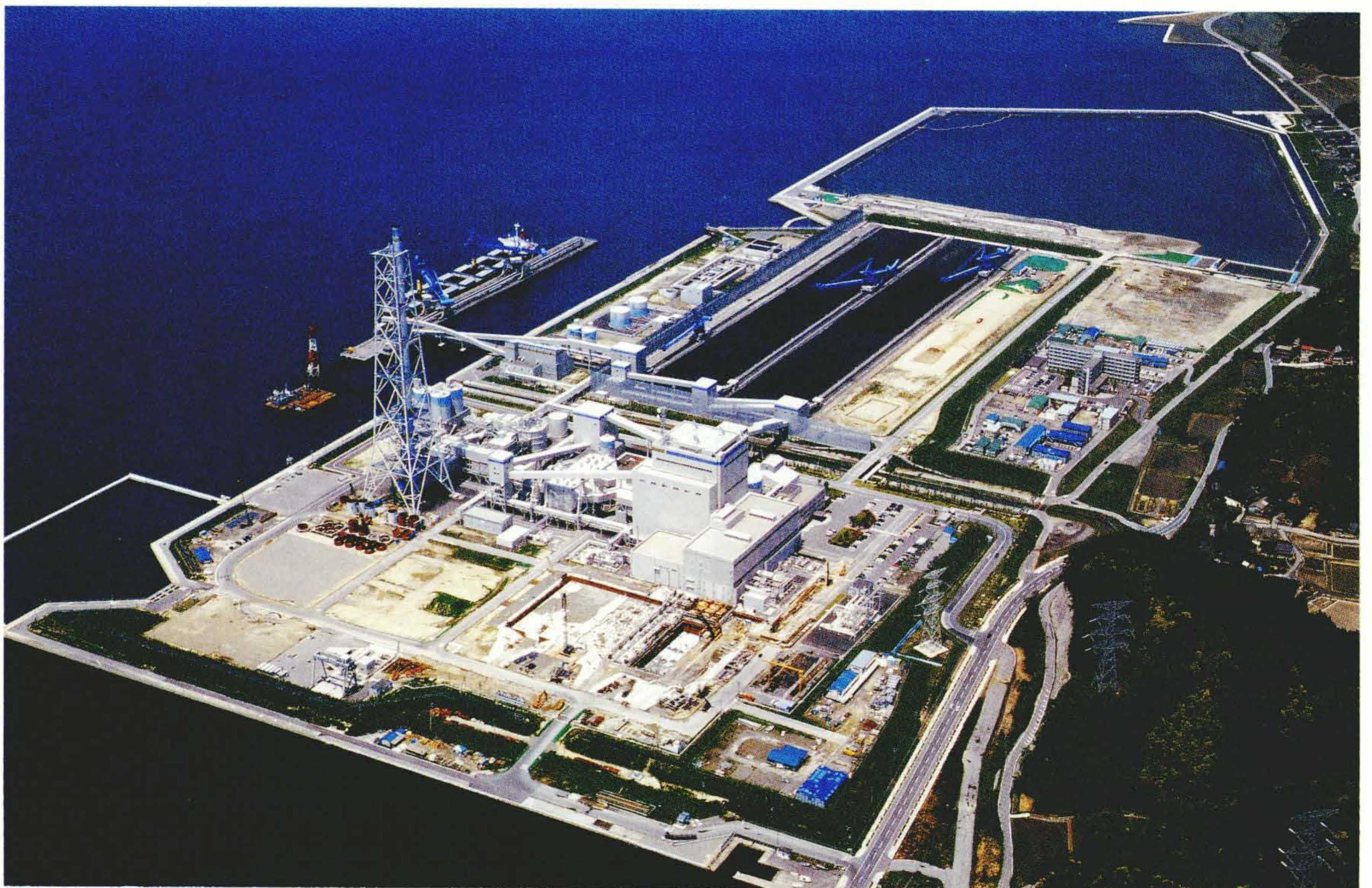
北陸電力株式会社七尾大田火力発電所の全景
