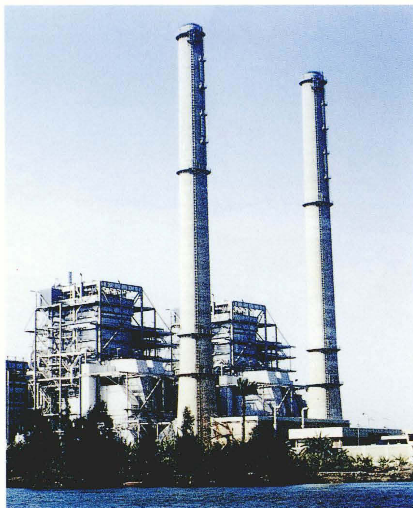
エジプト電力庁カイロウエスト発電所5、6号ボイラ
