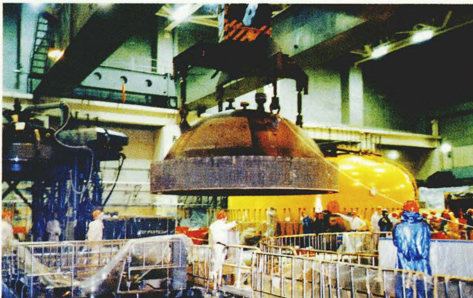
原子炉圧力容器上ぶた取り外し作業 (原子炉開放工程の主作業であり、本作業を含め入念な計画によって開放工程を2日間短縮した。)
