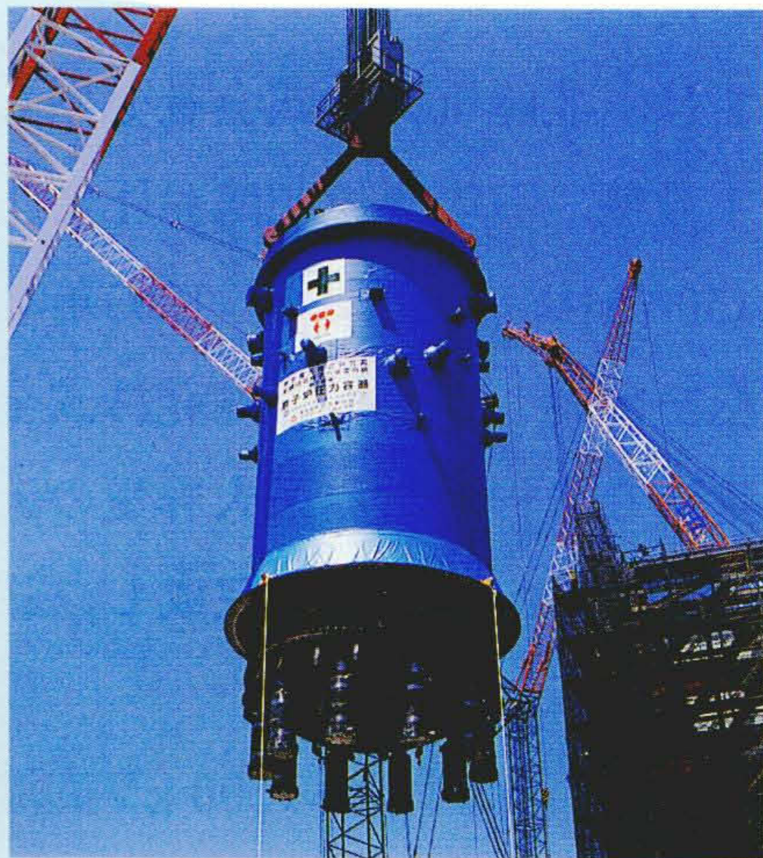
7号機原子炉压力容器搬入状況
