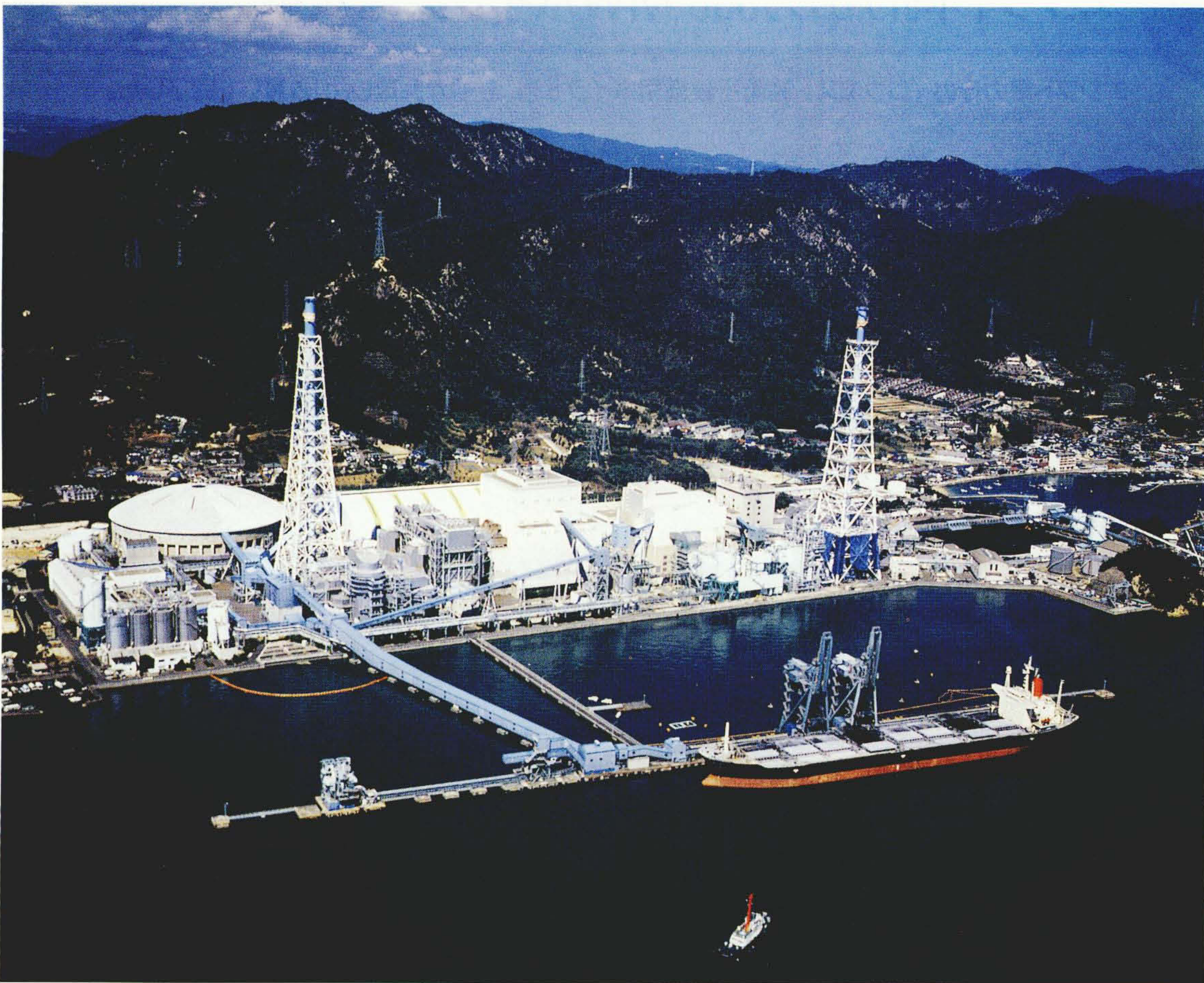
電源開発株式会社竹原火力発電所第2号流動床ボイラ(中央が2号機)
