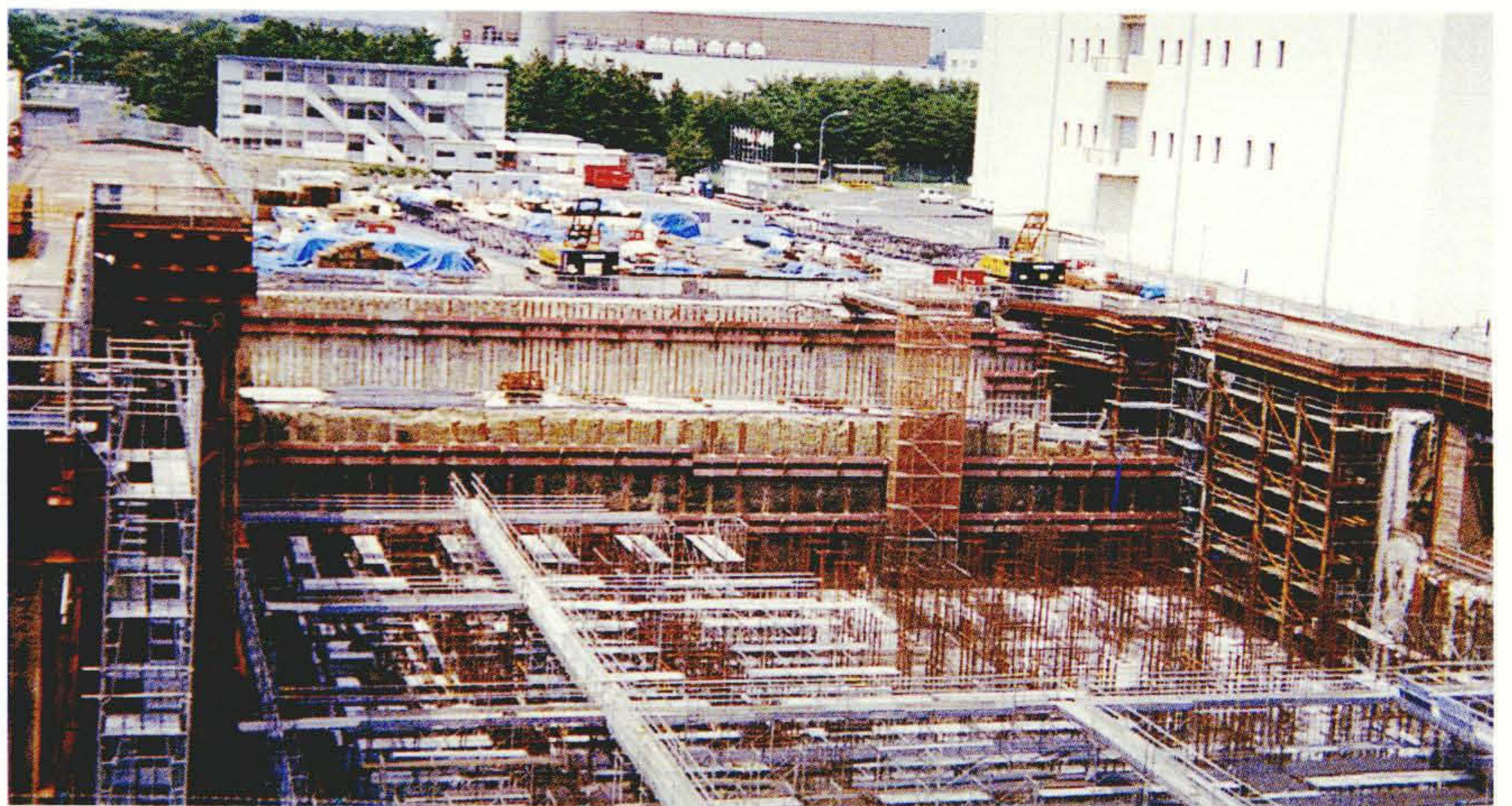
動力炉・核燃料開発事業団RETFの建設状況(1995年8月撮影)
