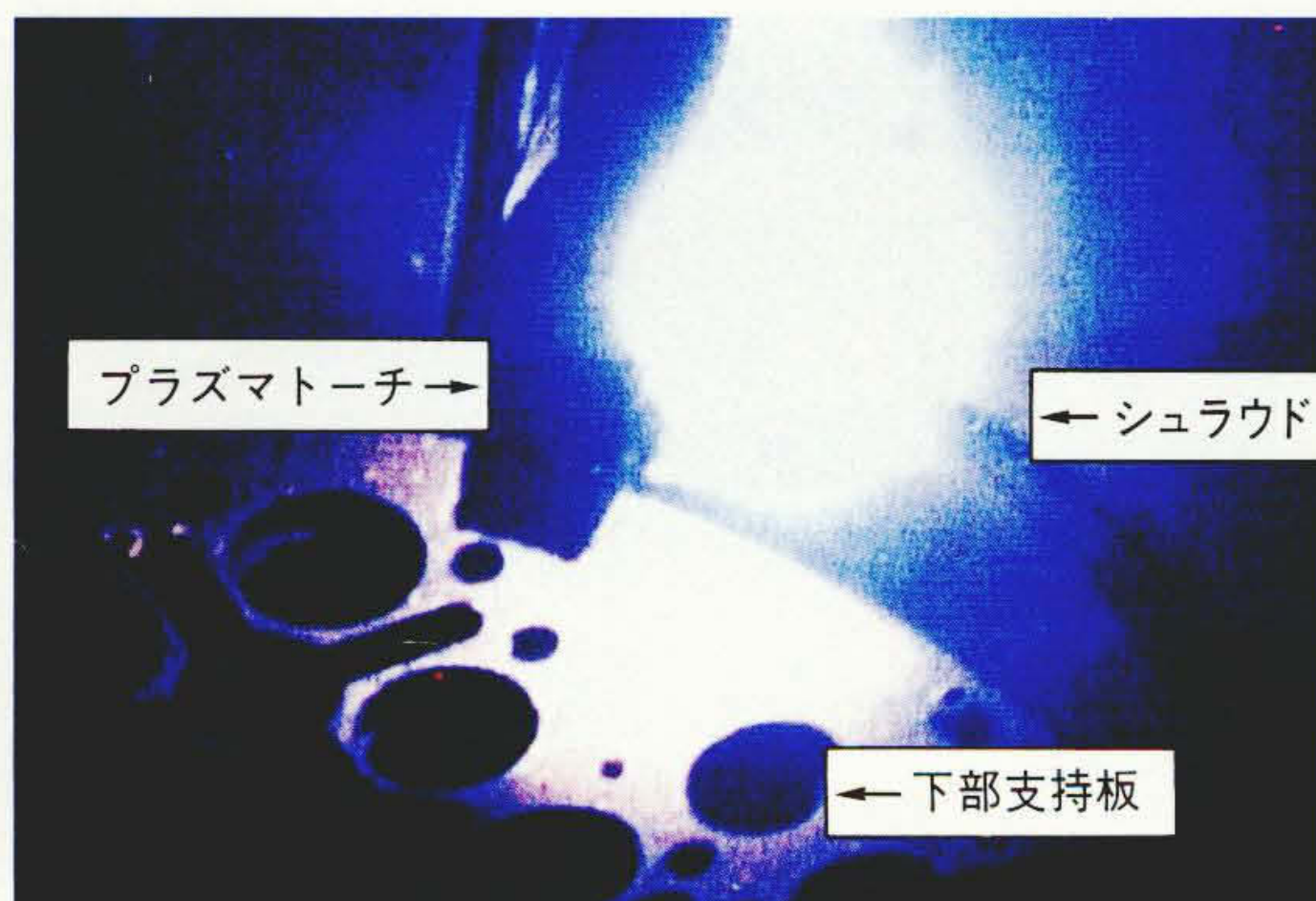
プラズマアーク切断によるシュラウド解体状況
