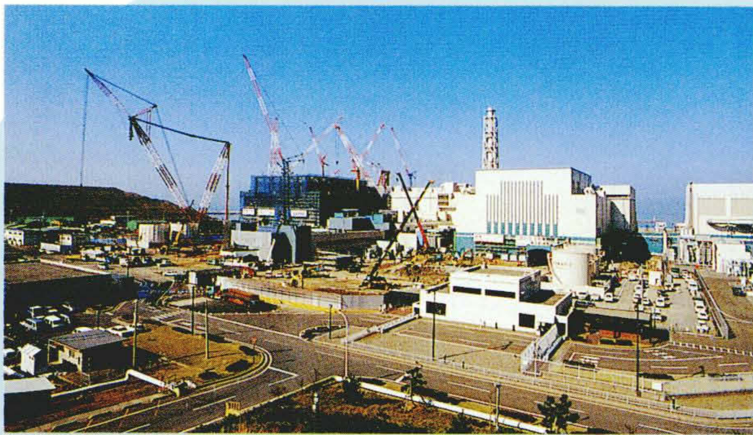
東京電力株式会社柏崎刈羽原子力発電所6,7号機建設現場
