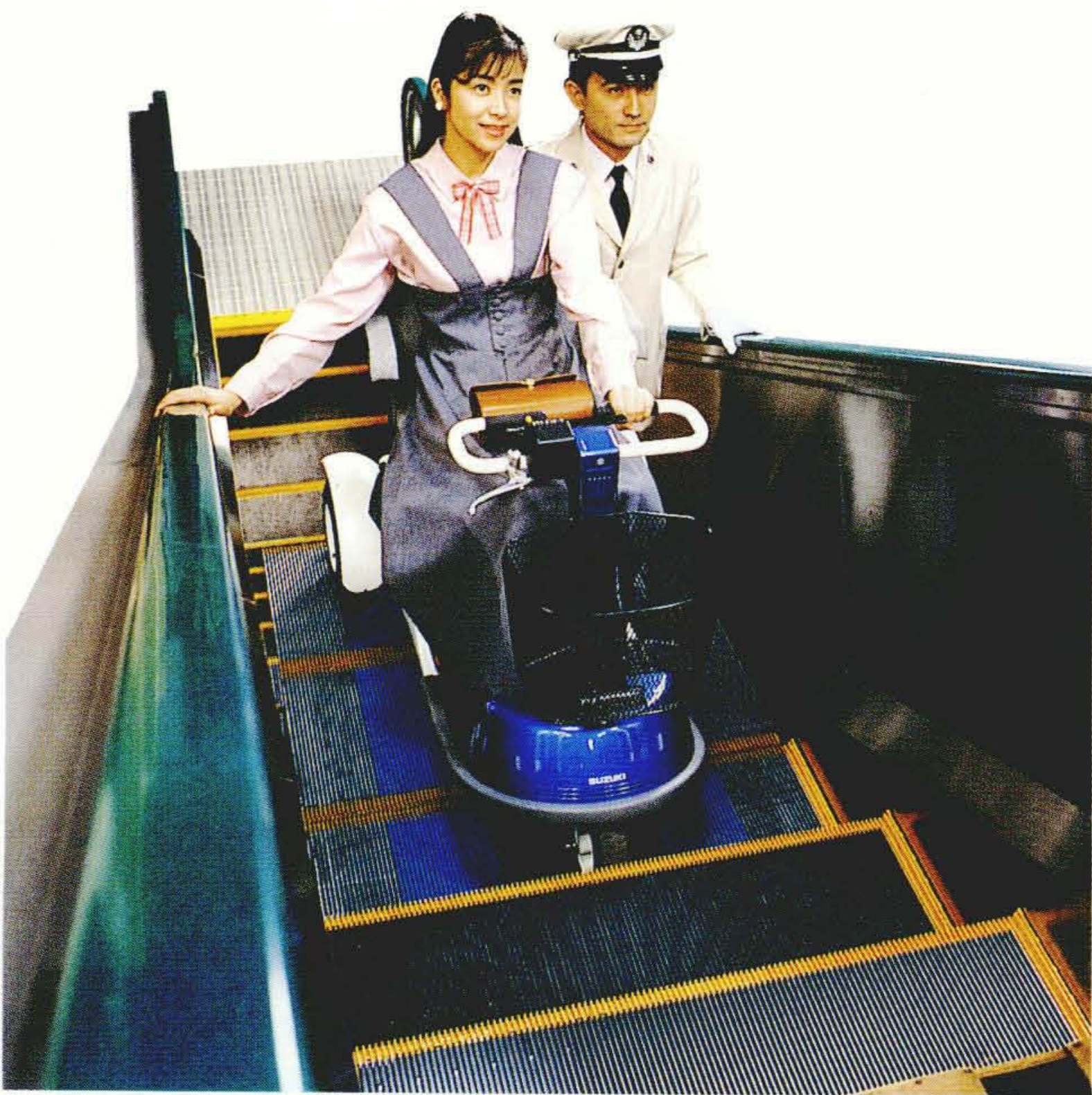
図10 大型電動車いす用ステップ付きエスカレーター 3枚ステップ水平方式により、電動三輪車を搭載することができる。
