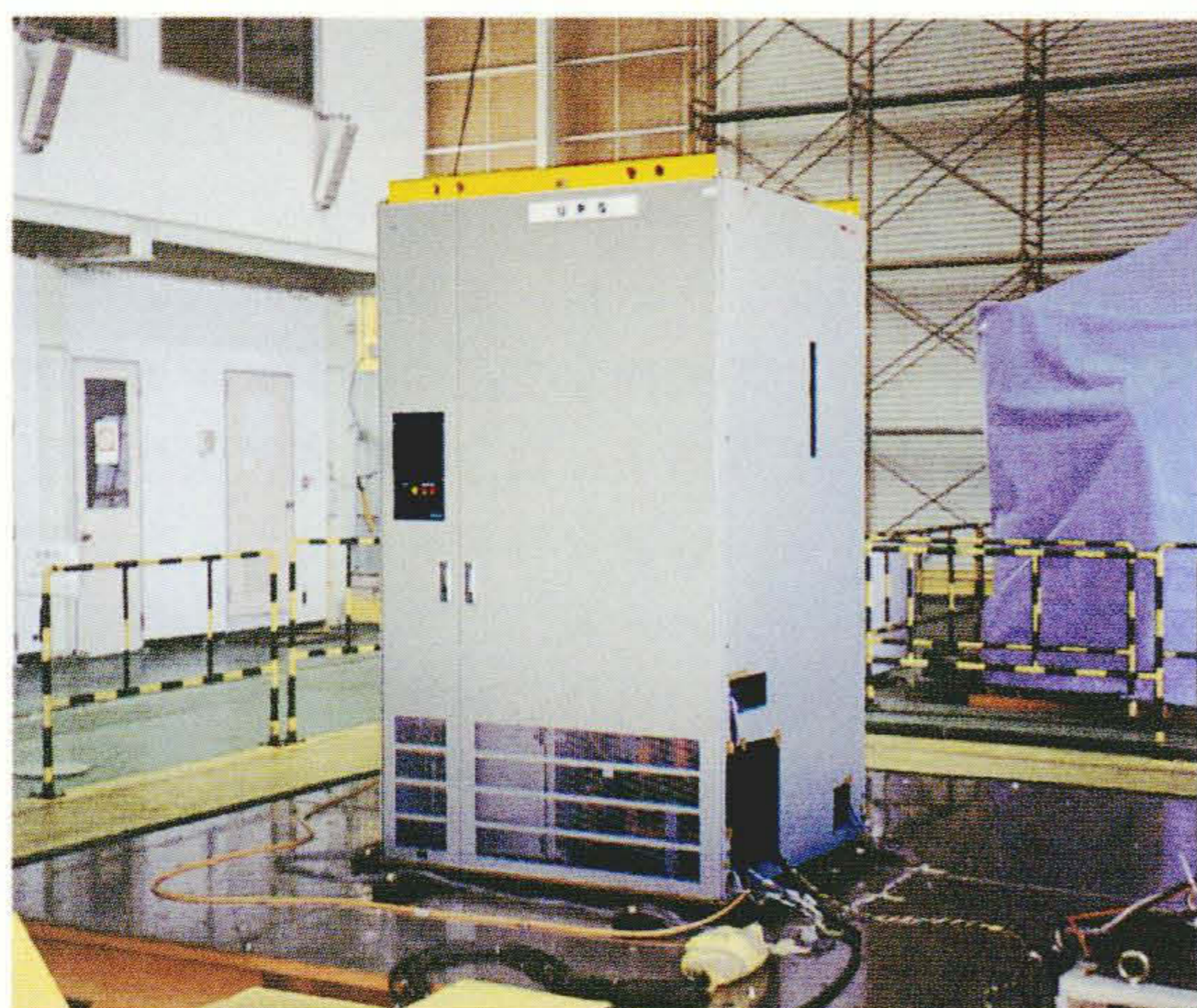
1,000 kVA UPSの耐震性検証試験(4面構造中の1面)
