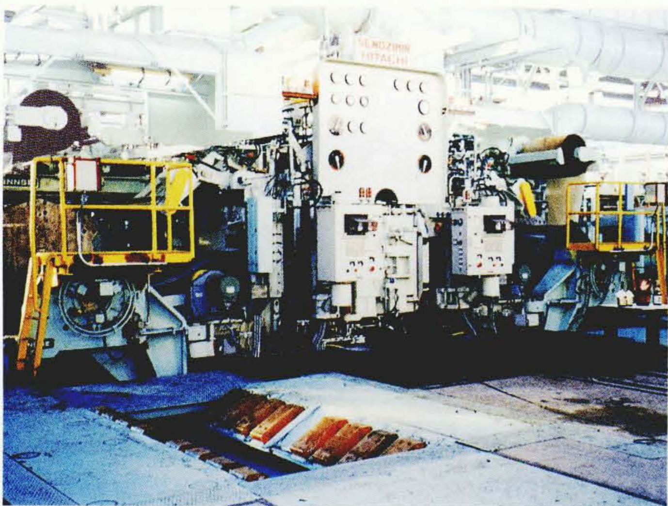
スペインACERINOX社納めKZR-MILL 2号機
