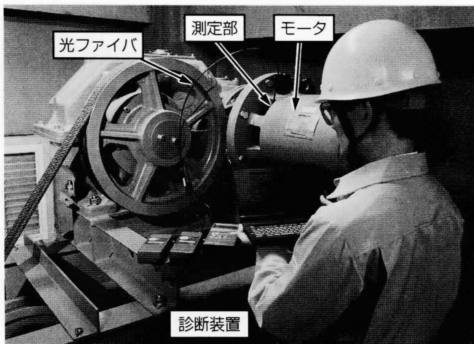
図4 熱劣化診断の様子
