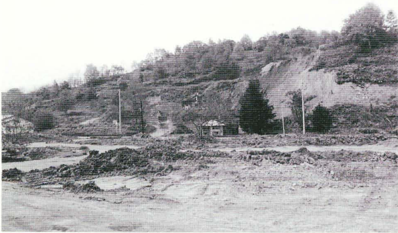
図1 歌志内リサイクル発電所の建設予定地
