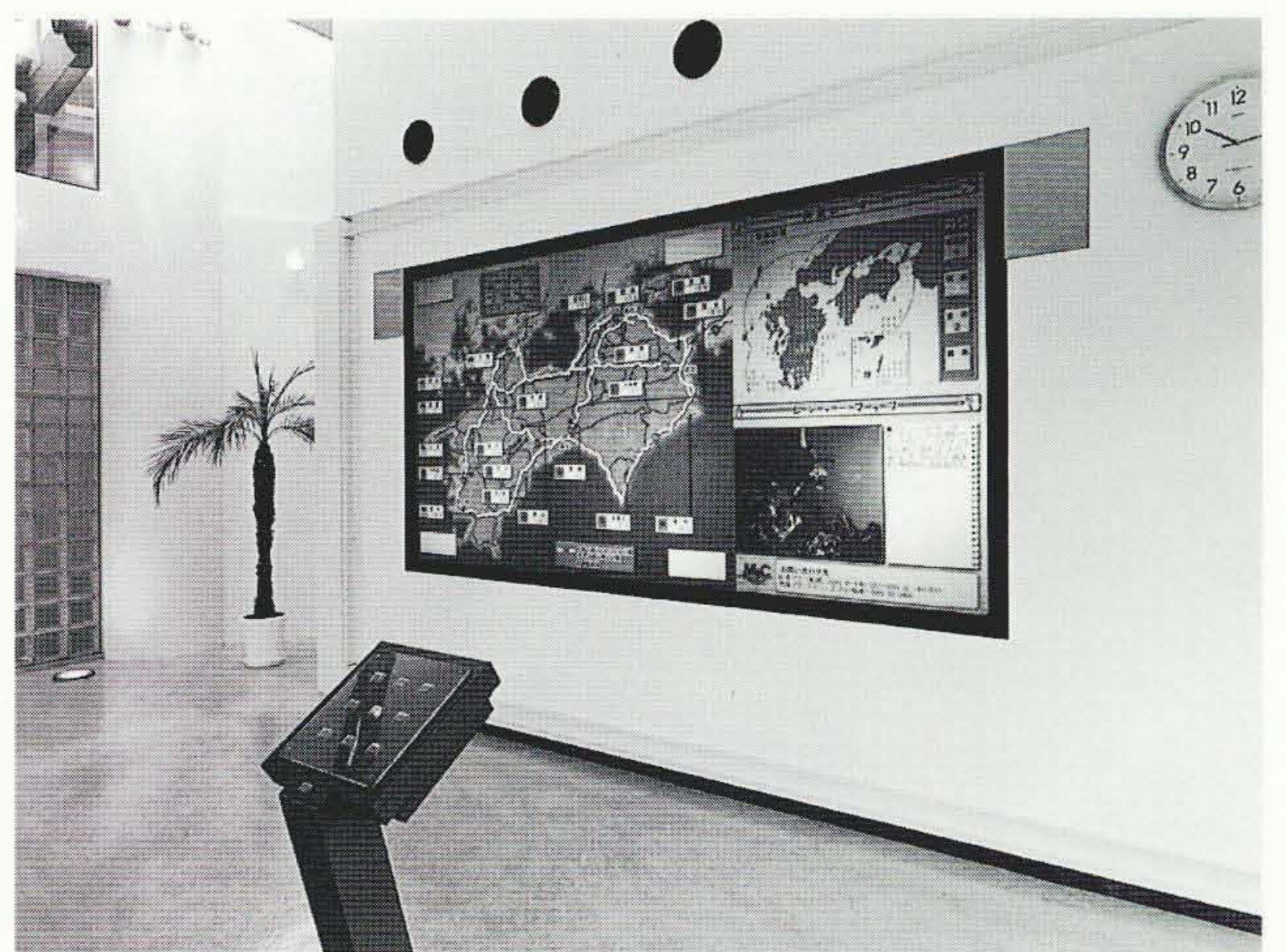
図3 道の駅「みしょうMIC」での情報提供システムの50型6面マルチビジョンと操作パネル
