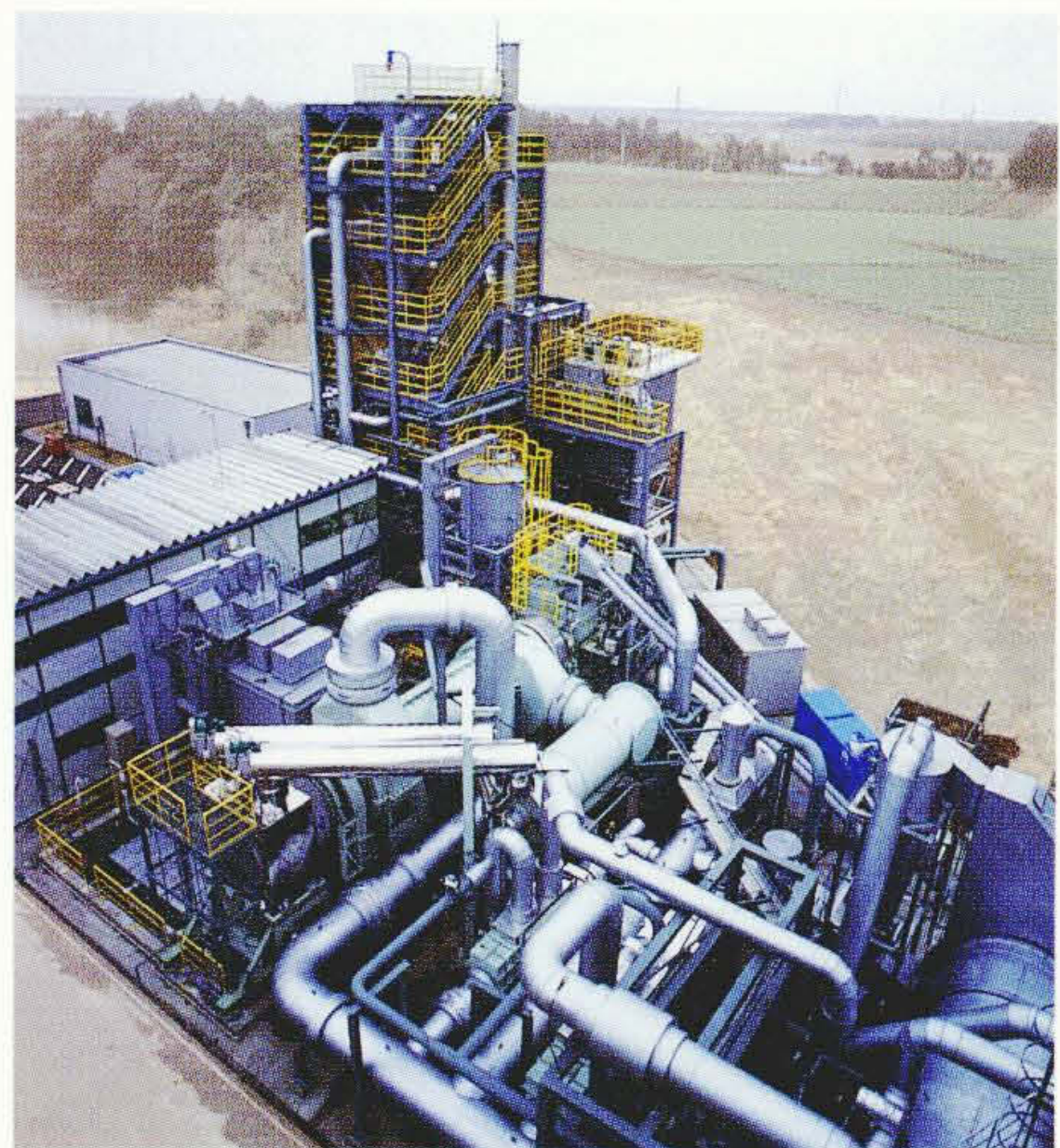
キルン式ガス化溶融システムの実証プラント
