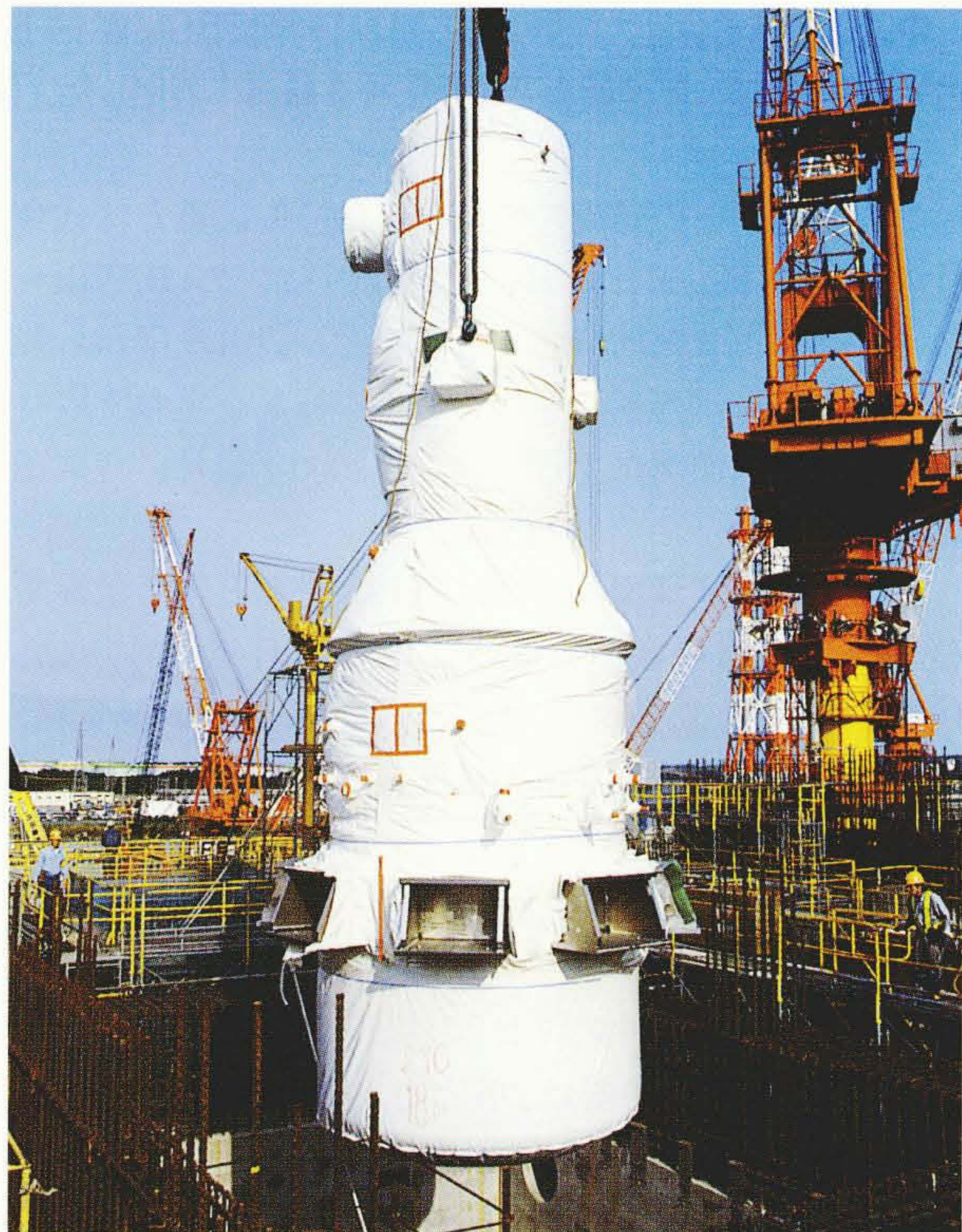
軽水炉燃料再処理施設用高レベル廃液濃縮缶の搬入状況
