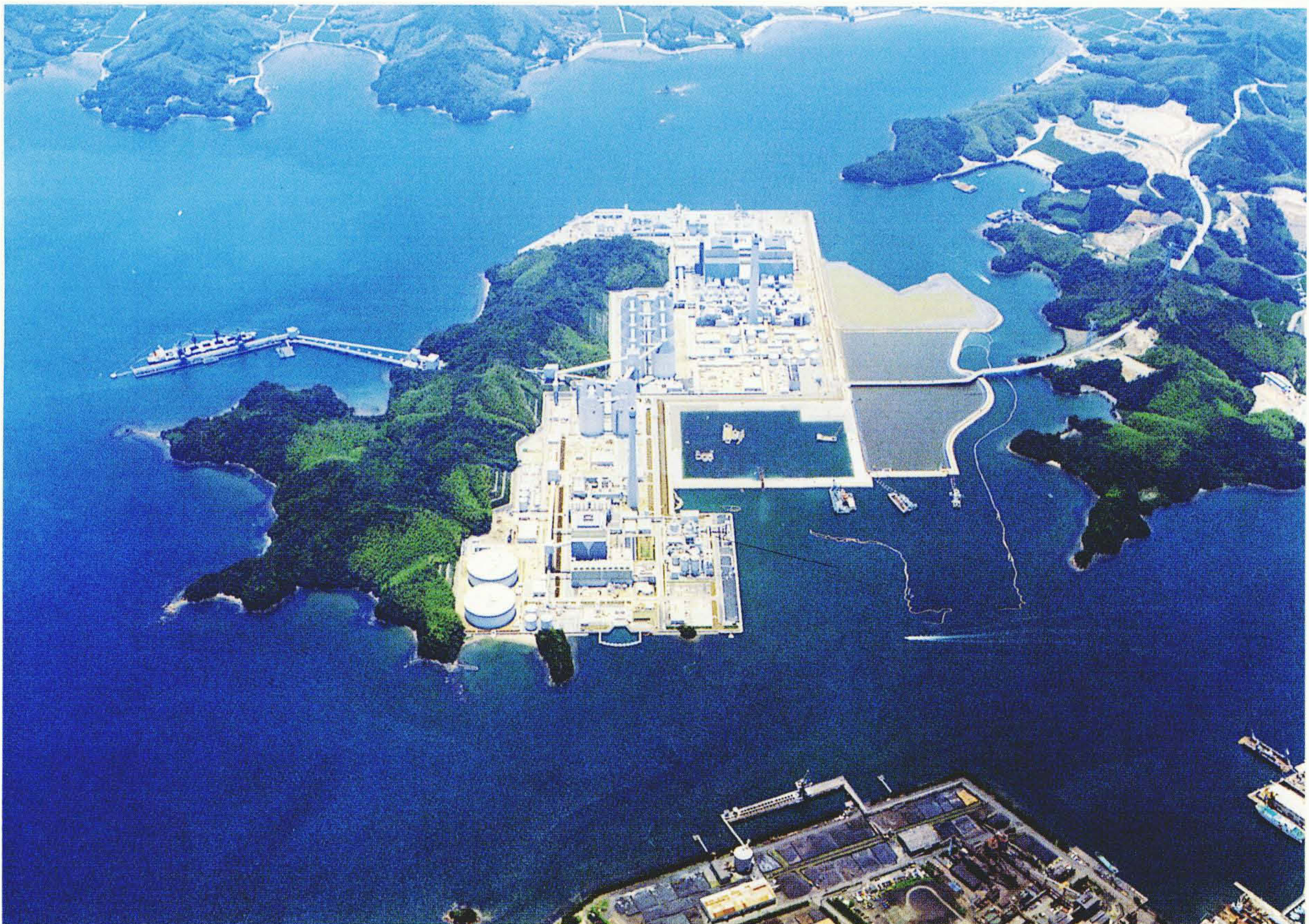
四国電力株式会社橘湾発電所(左下)と電源開発株式会社橘湾火力発電所2号機(右上)の外観
