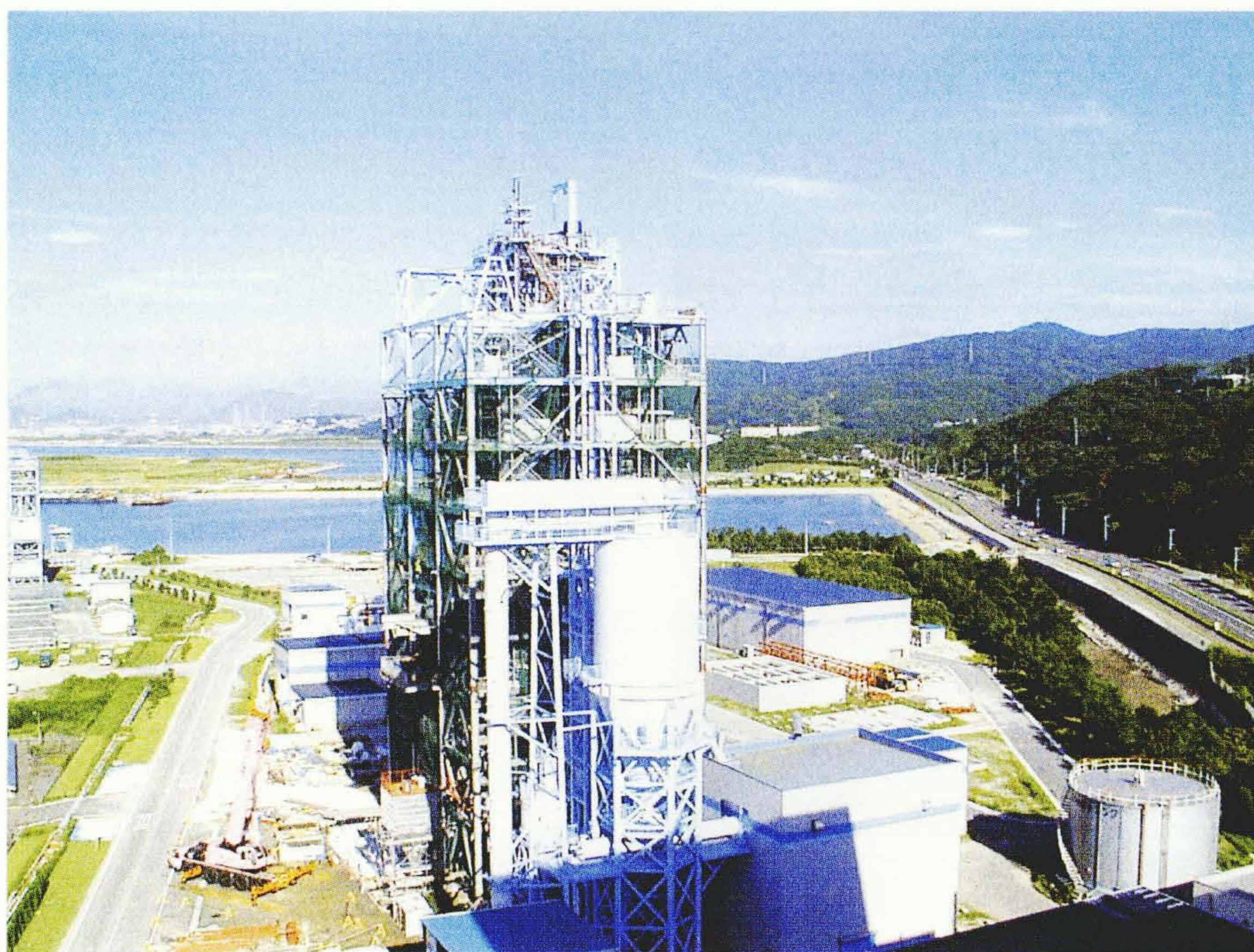
EAGLEパイロットプラントの建設状況
