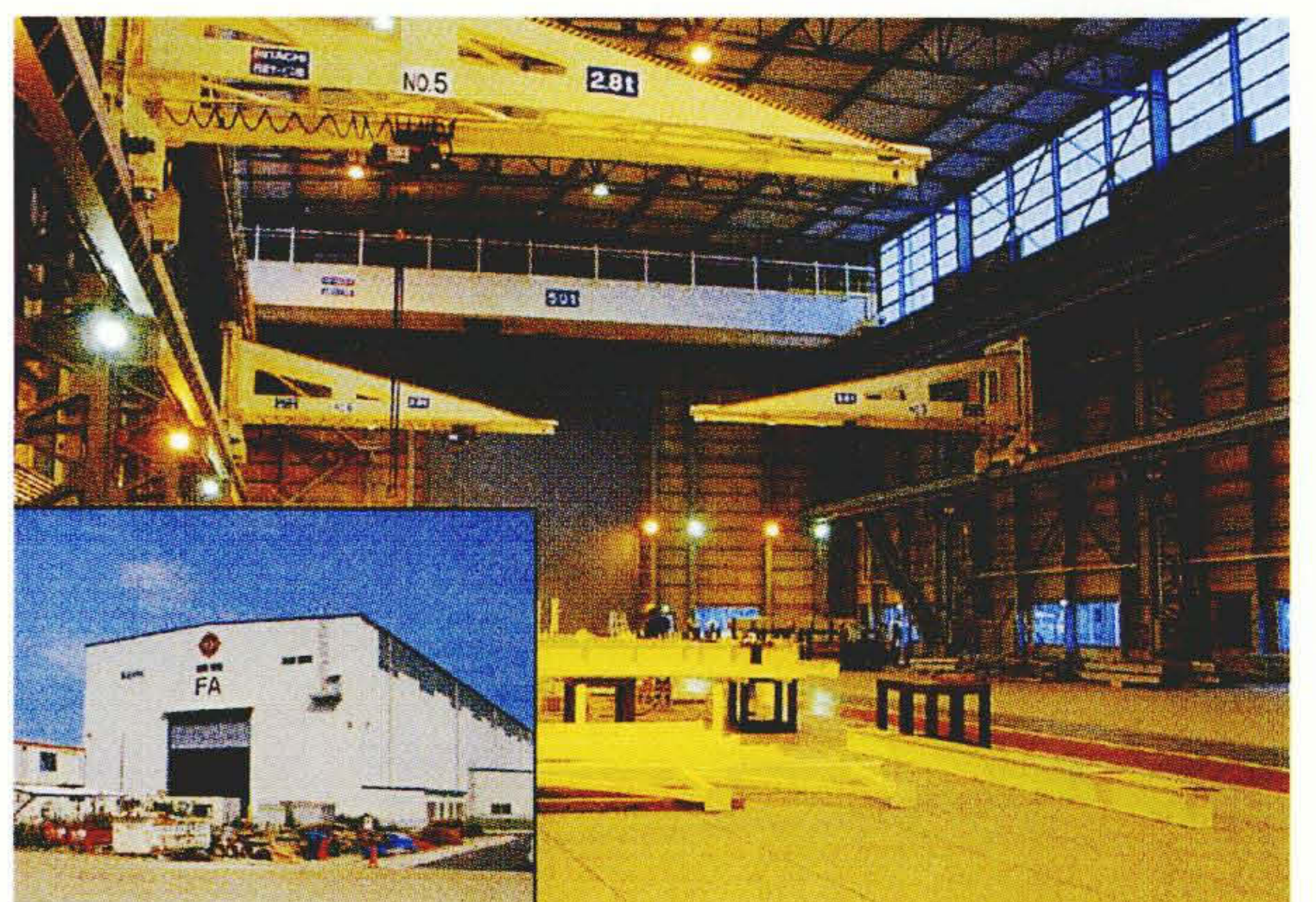
原子力モジュール工場の内部(上)と外観(左下)
