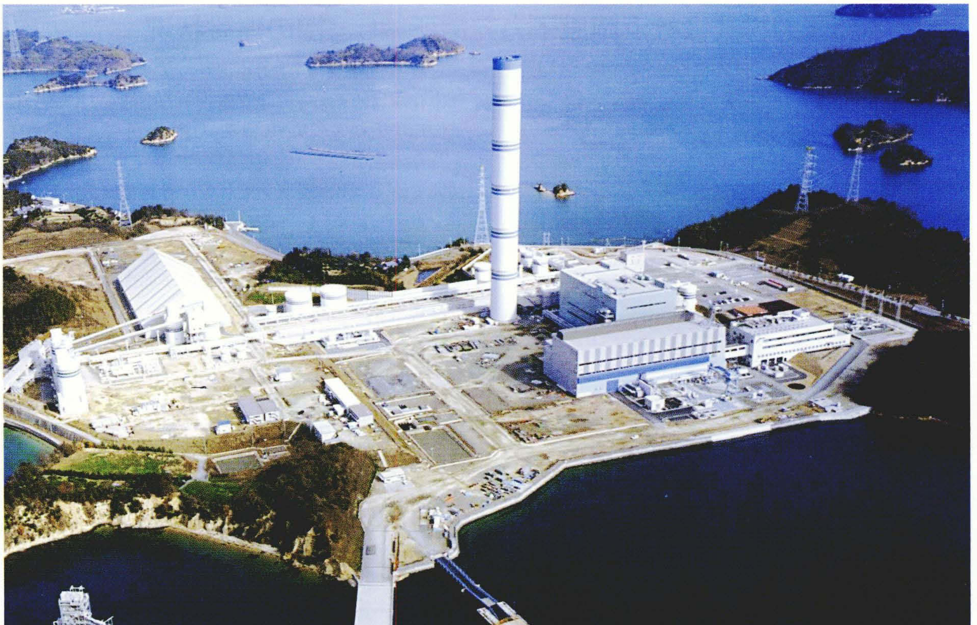
中国電力株式会社大崎発電所納め250 MW PFBC発電設備の外観
