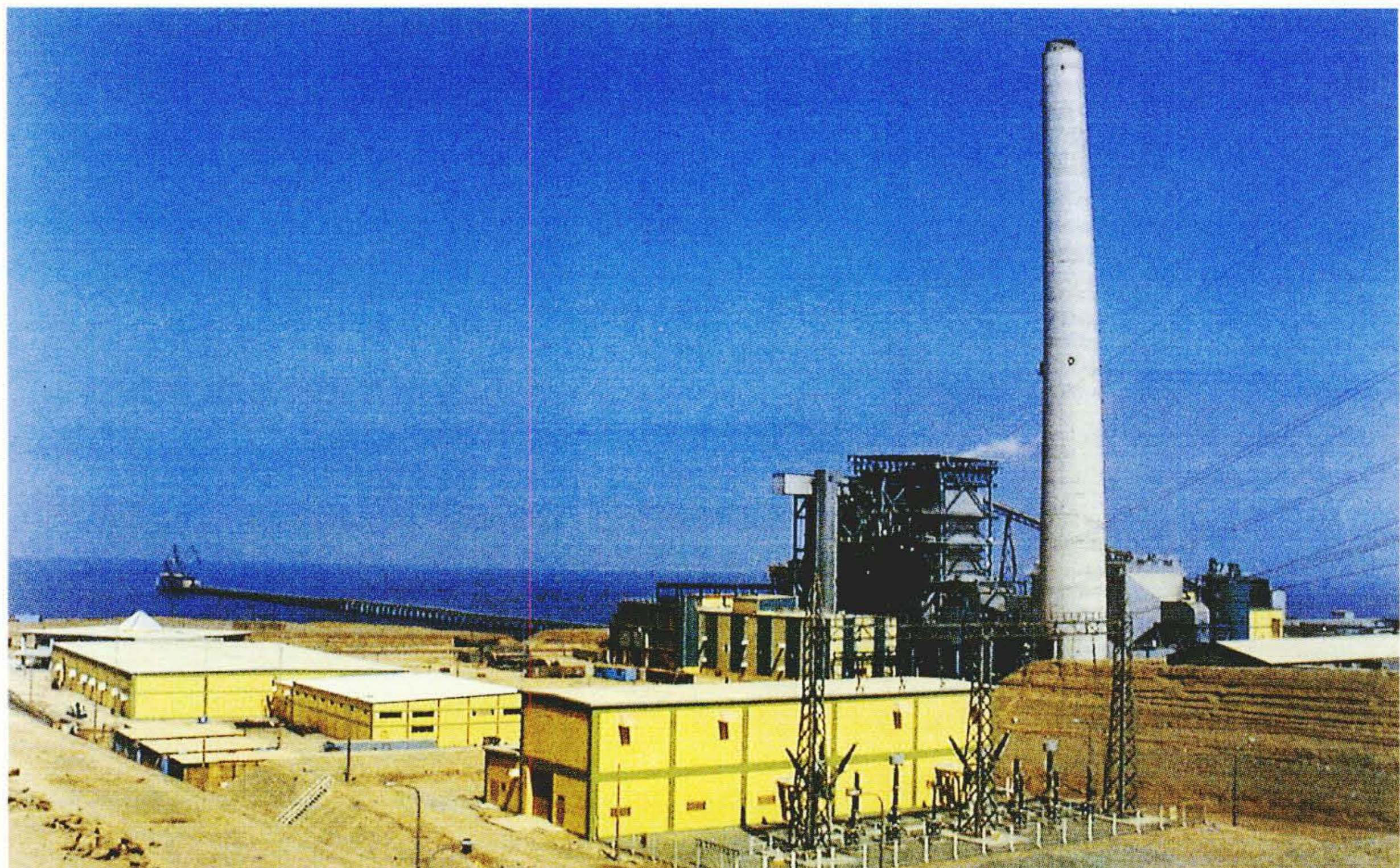
ペルー国イロ第2発電所1号機の外観
