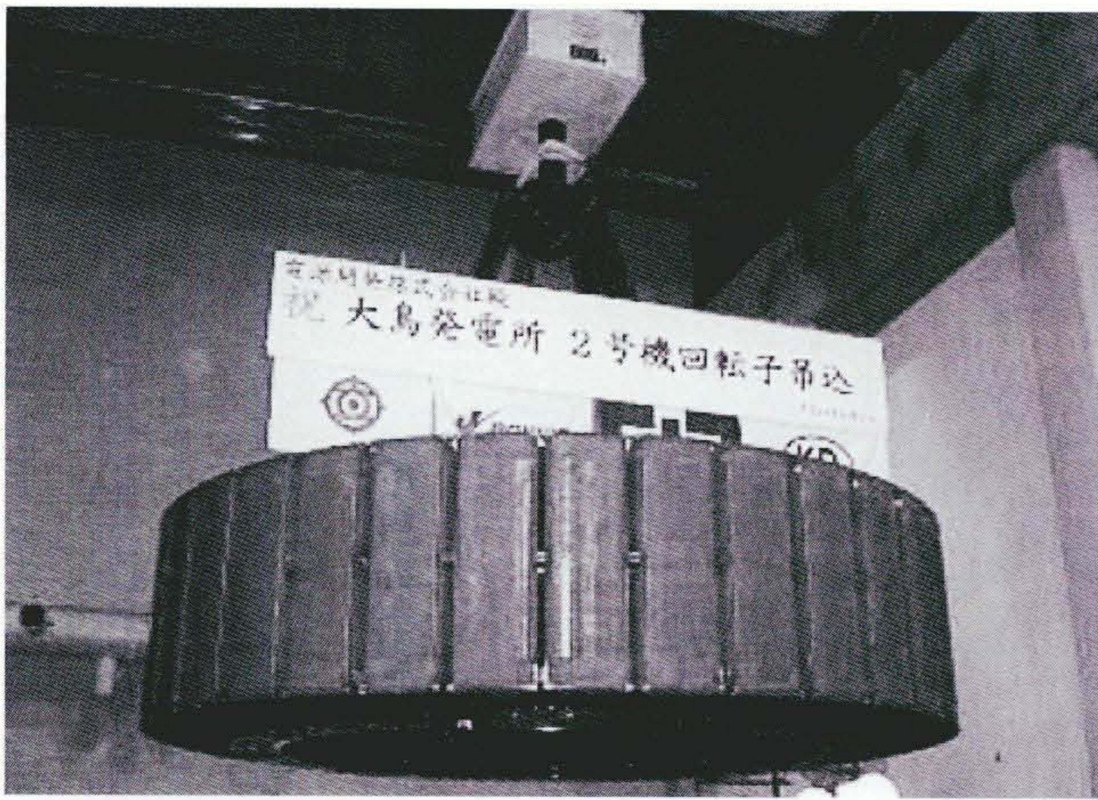
図5 2号機発電機回転子の現地組立
