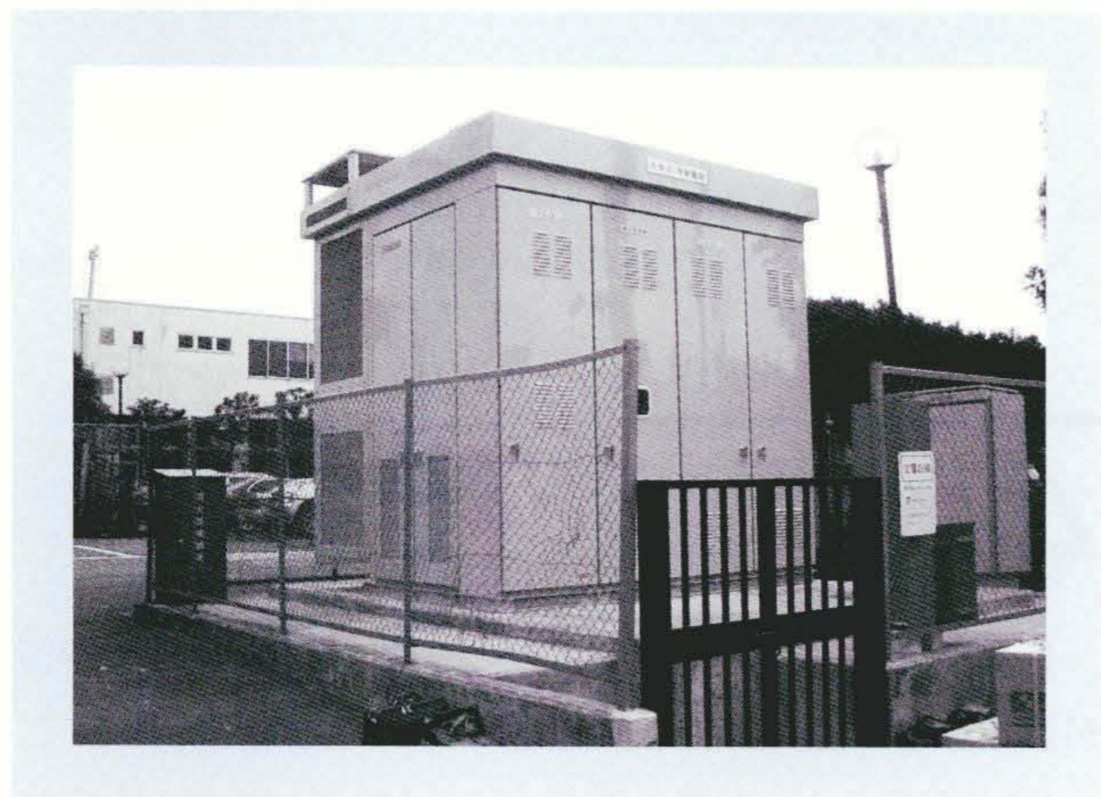
図5 22 kV/6 kV大容量配電塔の外観
