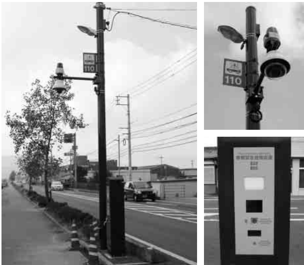
図3 スーパー防犯灯の設置例
