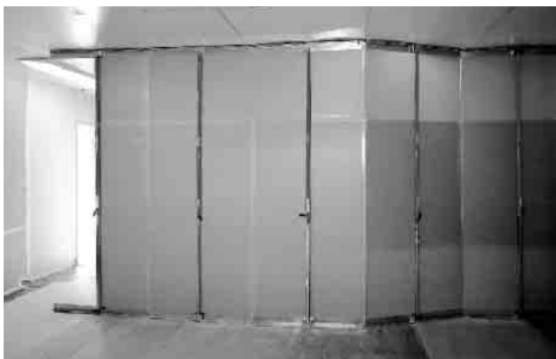
図8 防じん用簡易間仕切り
