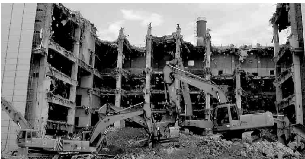
図2 ビル解体現場で活躍する日立建機の解体機
