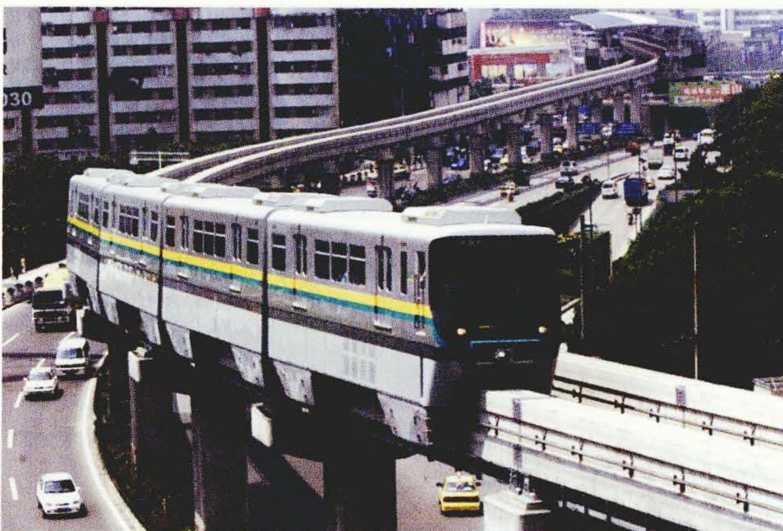
試験走行中の重慶モノレール車両
