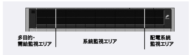
図3 大規模映像装置(給電監視盤)システムの表示エリア 需給、系統および配電監視に必要な情報をリアプロジェクト採用により、用途別にダイナミックで視認性のある映像で表現する。
