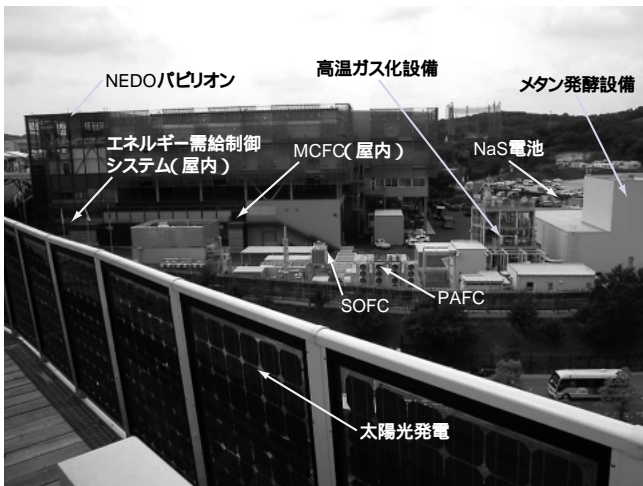
図5 愛知万博の「新エネルギー等地域集中実証研究」設備(NEDO技術開発機構連携実証研究プラント)の概要 エネルギー需給制御システムに発電計画機能と電力品質計測・評価機能を適用した。
