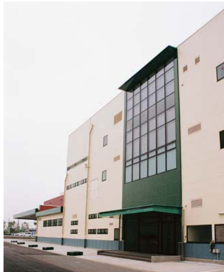
長谷川香料株式会社納め食品香料プラントの外観
