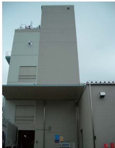
新日本石油化学株式会社納め液晶ポリマープラントの外観
