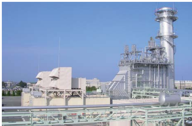
日立臨海発電所第2号機
